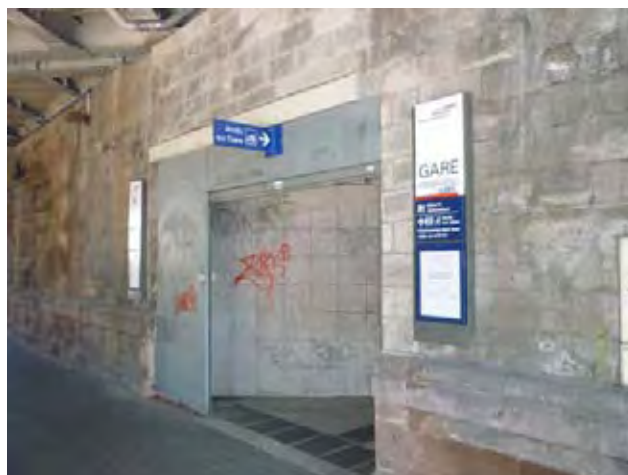
Unique point d'entrée dans la gare (photo Cete de l'Est)
