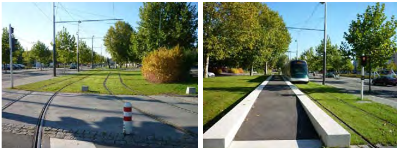
La voie de la Fédération : voie de débranchement créée en 2007 au droit du stade (photos Cete de l'Est)
