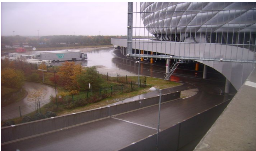
Vue de l'accès au parking S0 (photo Cete de l'Est)
