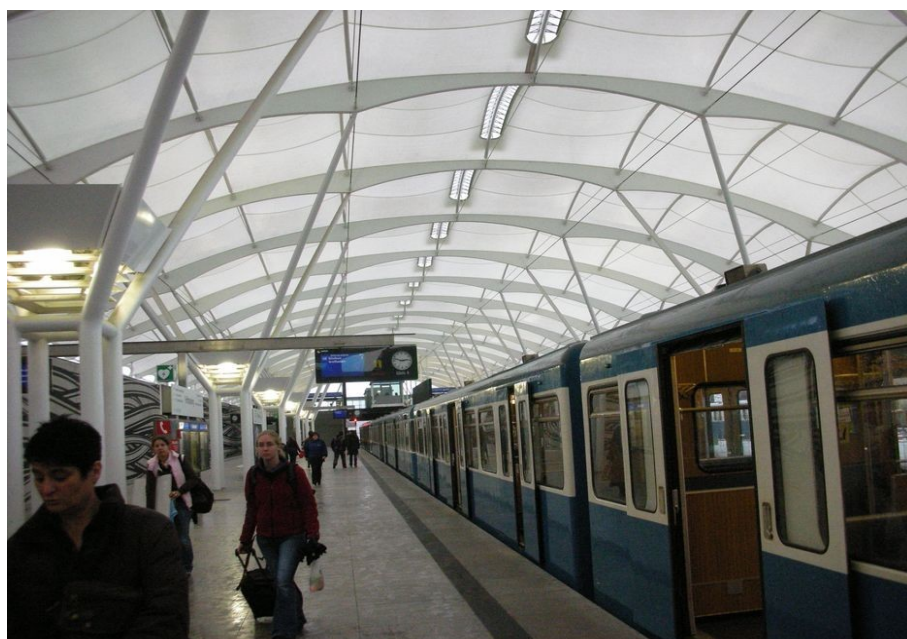
Station Fröttmaning – Vue des rames et des quais
