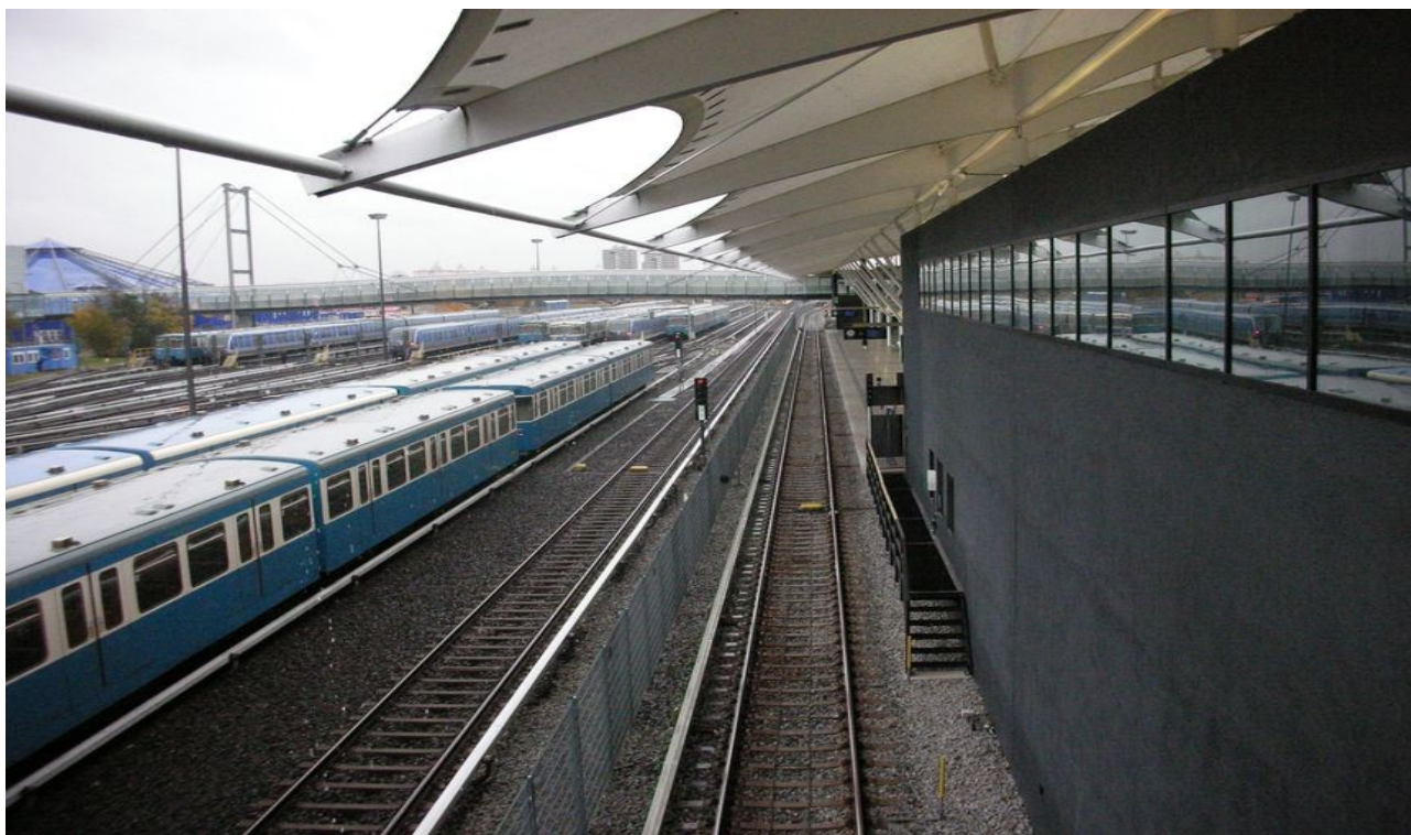
Vue de la seconde passerelle piéton couverte donnant sur le P+R et le théâtre (photo Cete de l'Est)
