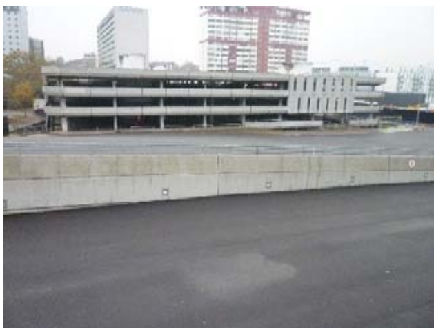
Le parking rouge en ouvrage (photo Cete de l'Est)
