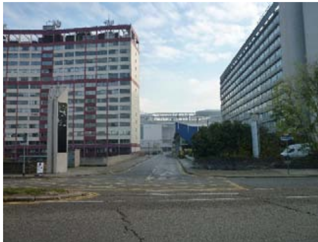
Immeubles de bureaux à l'ouest (photo Cete de l'Est)
