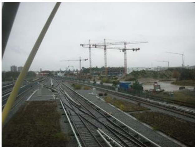
Vue des travaux de construction dans le quartier de Fröttmaning depuis la passerelle sud (photo Cete de l'Est)
