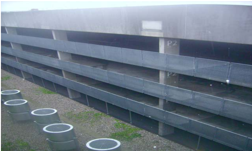
Vue du parking P2 :chacun des 3 parcs comprend 4 niveaux (photo Cete de l'Est)
