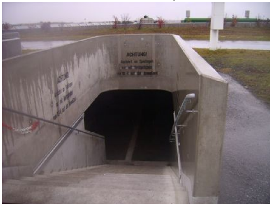
Exemple d'une entrée piétonne de parking
