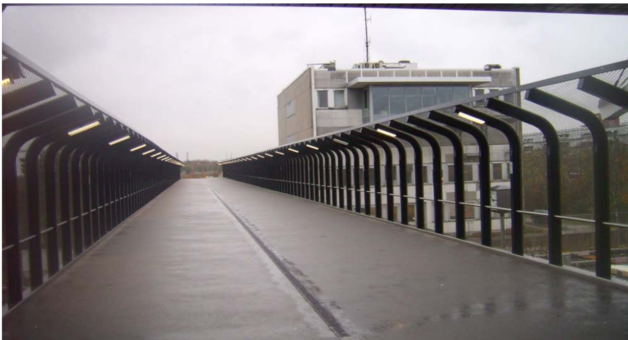
Vue de la passerelle non couverte menant à l'esplanade (photo Cete de l'Est)
