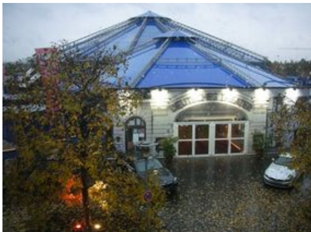
Chapiteau d'entrée du « Deutsches Theater » vu de la passerelle sud (photo Cete de l'Est)
