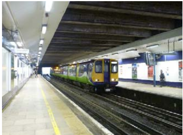
Overground en gare de Wembley-Central (photo Cete de l'Est)
