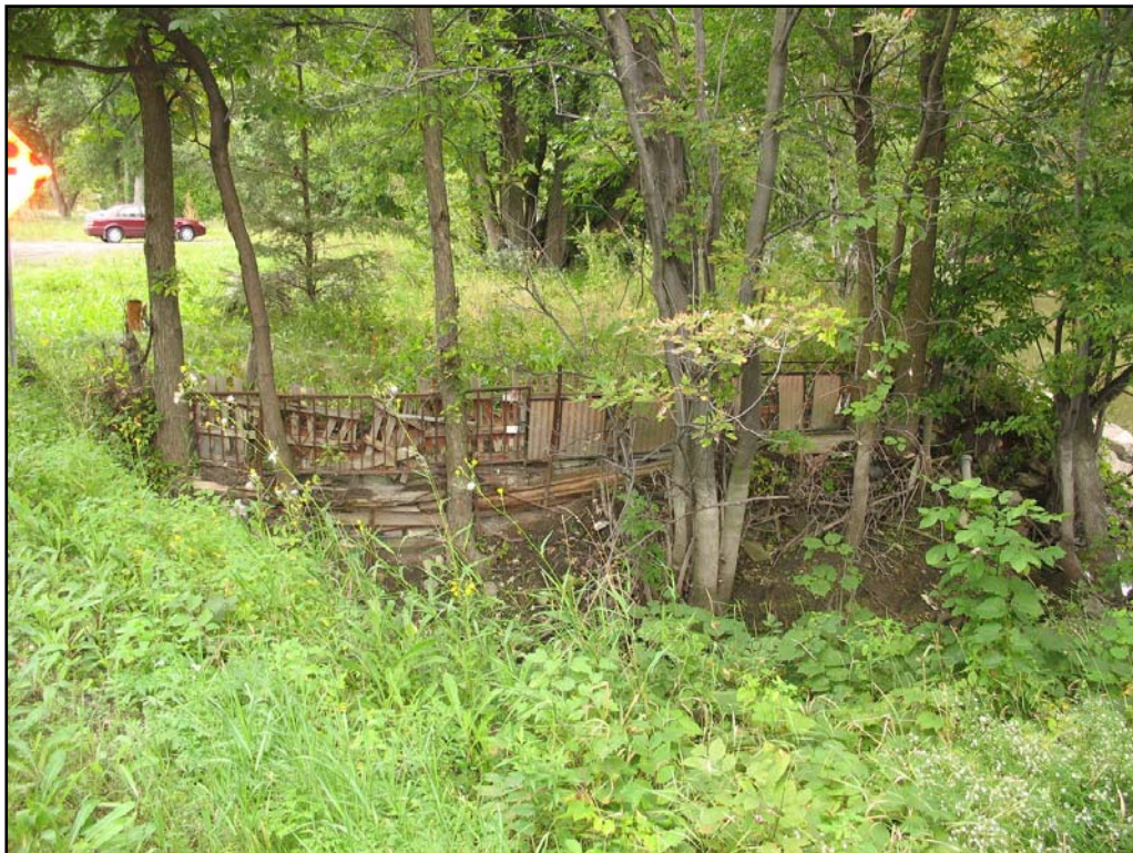
Photo 15 : Remblai et aménagement sur la rive ouest de la rivière L'Acadie, direction nord-ouest (154-93-1294-08-NUM1-12)
