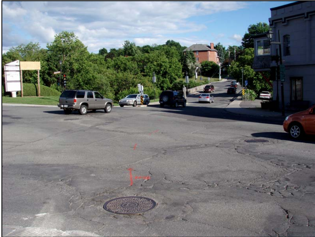
Photo 1 : Pont n° P-14443, intersection des rues Principale, Mountain et Drummond, direction sud-est (154-07-2200-08-NUM1-20)
