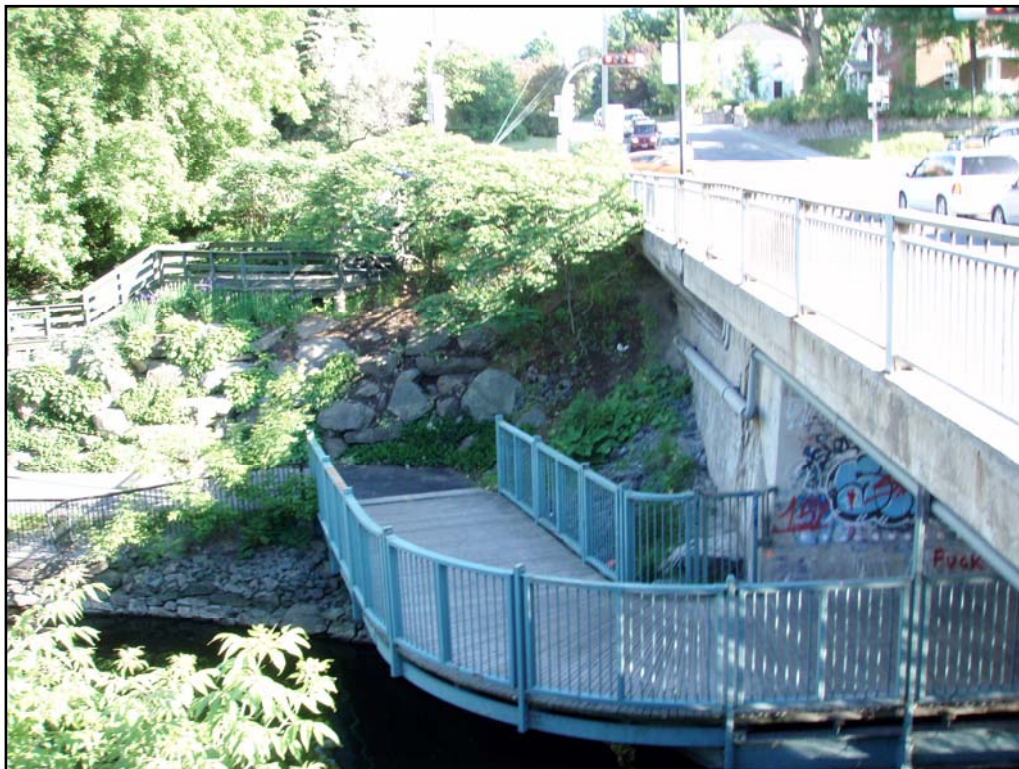
Photo 2 : Piste cyclable sous l'extrémité sud du pont n° P14443, direction sud (154-07-2200-08-NUM1-28)
