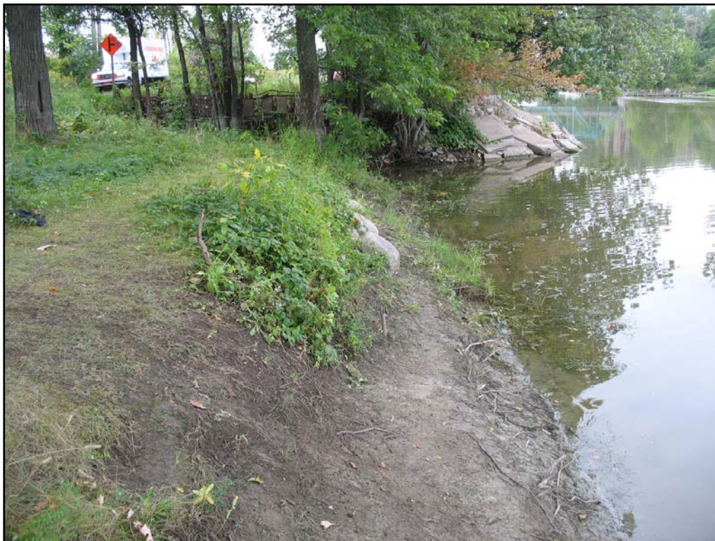
Photo 16 : Remblai et aménagement sur la rive ouest de la rivière L'Acadie, direction nord (154-93-1294-08-NUM1-13)
