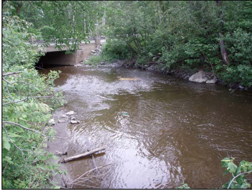
Photo 7 : Pont P-16818, ruisseau Gear du côté ouest de la route 104, secteur 3, direction est (154-07-0881-08-NUM1-39)
