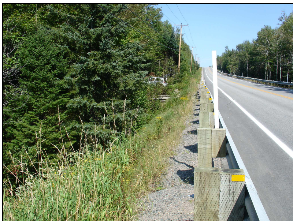
Photo 12 : projet 154-07-0404, municipalité de Saint-Tite, route 153, aperçu général de l'emprise, côté nord de la route, est du ponceau, direction est.
