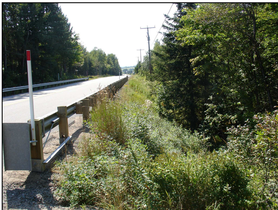
Photo 11 : projet 154-07-0404, municipalité de Saint-Tite, route 153, aperçu général de l'emprise, côté nord de la route, ouest du ponceau, direction ouest.
