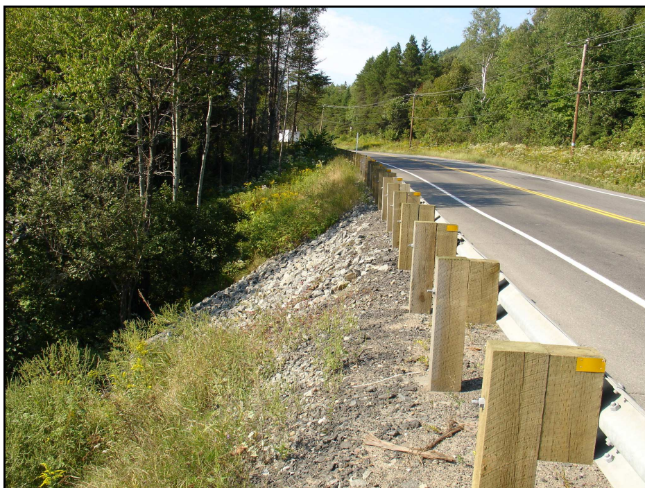
Photo 3 : projet 154-07-0299, municipalité de Saint-Rock-de-Mékinac, route 155, aperçu général de l'emprise, direction nord.
