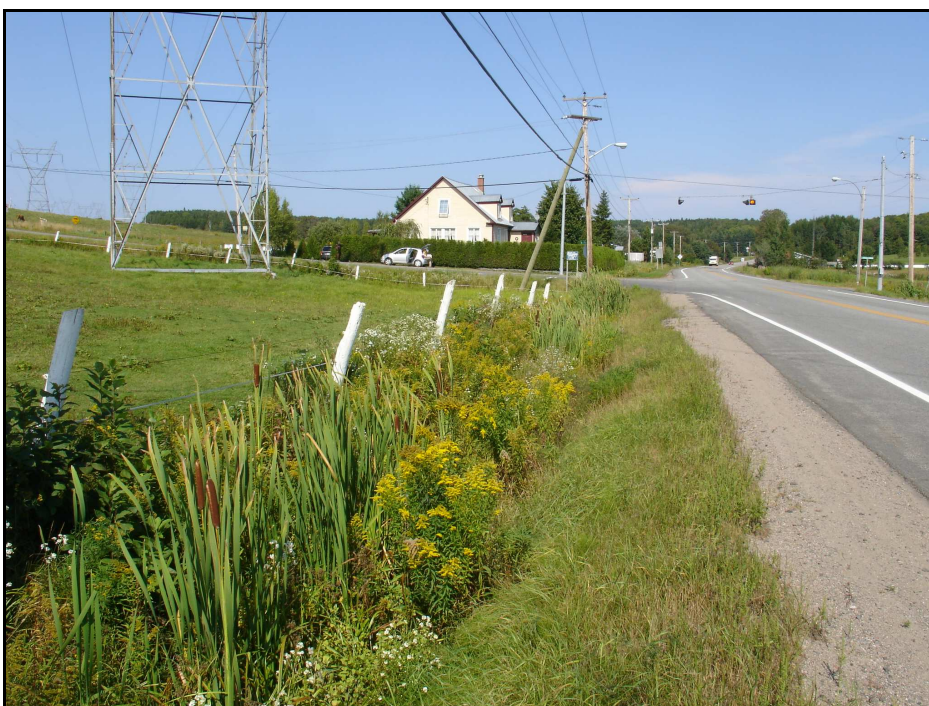
Photo 14 : projet 154-07-0402, municipalité de Saint-Tite, route 153, aperçu général de l'emprise, côté nord de la route, direction ouest.
