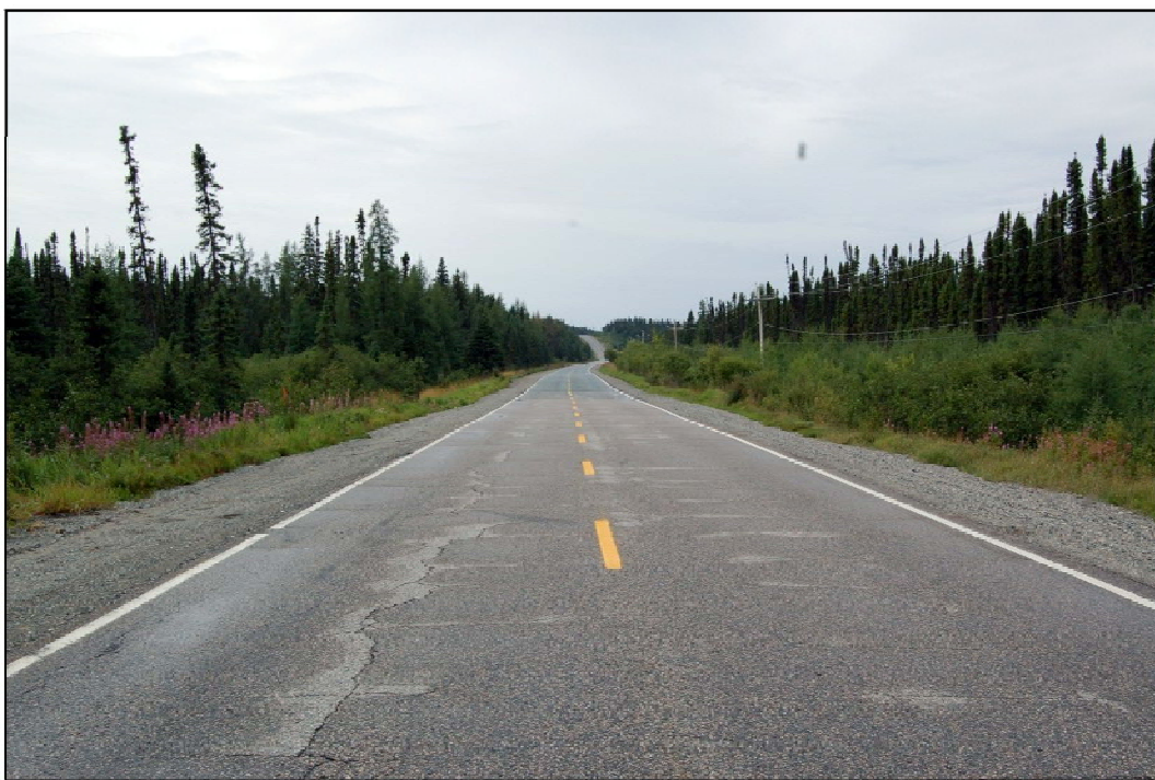
Photo 9 Projet n° 154-06-1515, environnement du secteur n° 9 (route 113, km 0 + 847), municipalité de Baie-James, direction sud-est (PATR07N7-42)
