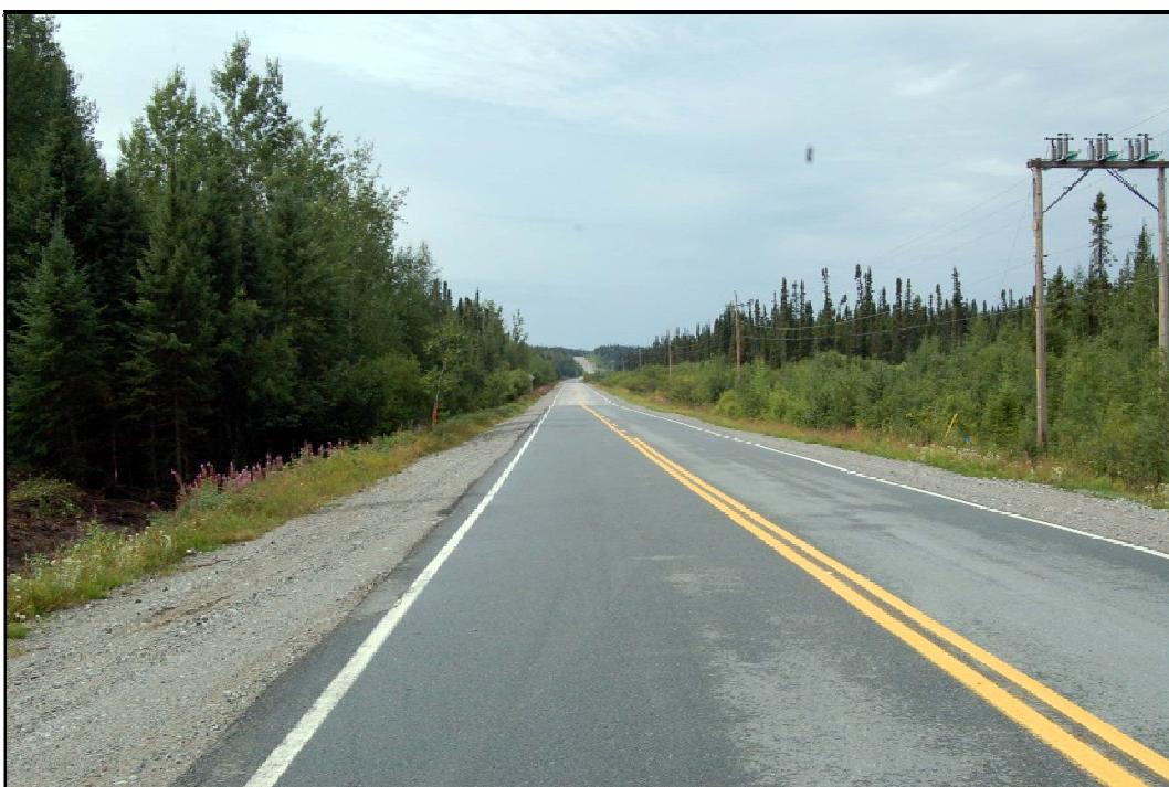
Photo 8 Projet n° 154-06-1515, environnement du secteur n° 8 (route 113, km 1 + 376), municipalité de Baie-James, direction sud-ouest (PATR07N7-45)
