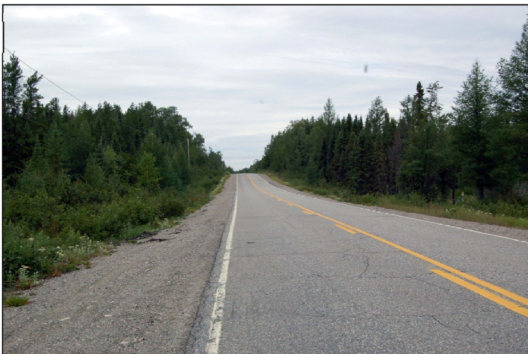
Photo 3 Projet n° 154-06-1515, environnement du secteur n° 3 (route 113, km 13 + 024), municipalité de Baie-James, direction nord-ouest (PATR07N7-52)
