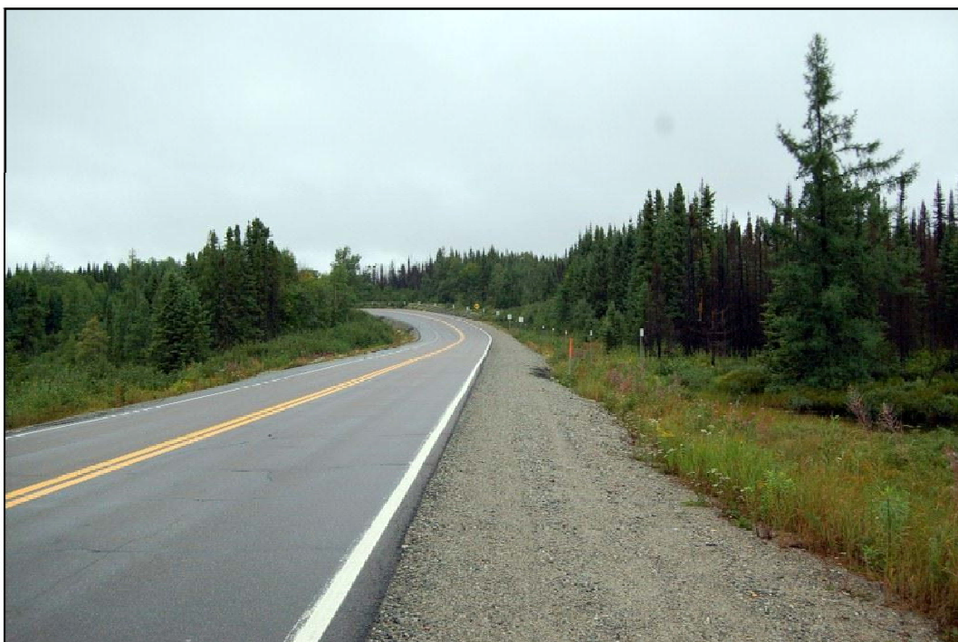
Photo 31 Projet n° 154-06-1515, environnement du secteur n° 11 (route 167, km 3 + 332), municipalité de Baie-James, direction nord-ouest (PATR07N7-65)
