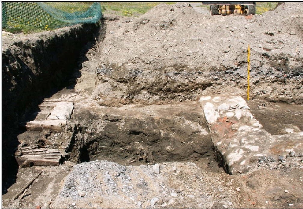
Photo 11 Site DdEa-4, sous-opérations 1B et 1D : vestiges d'ouvrages en bois et en maçonnerie, direction nord (PATR06N03-021)
