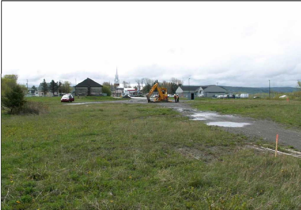
Photo 7 Secteur 1, partie sud : vue générale à partir du km 0+736, direction sud (PATR06N03-001)
