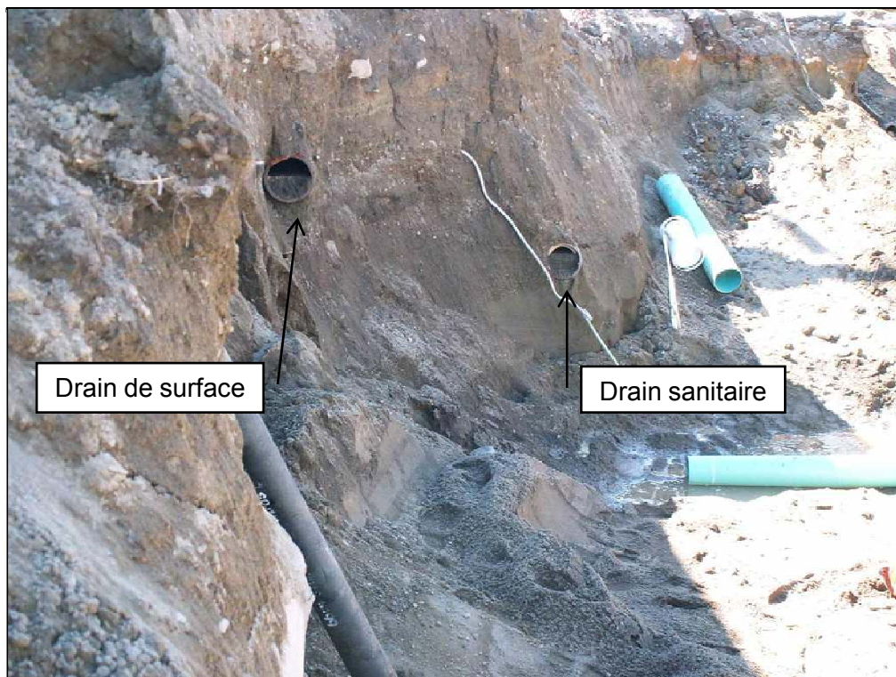
Photo 5 Secteur 8, rue Saint-Rémi, drain de surface et sanitaire domestique en grès, côté sud de l'emprise, km 0+685, direction ouest (PATR06N03-253)
