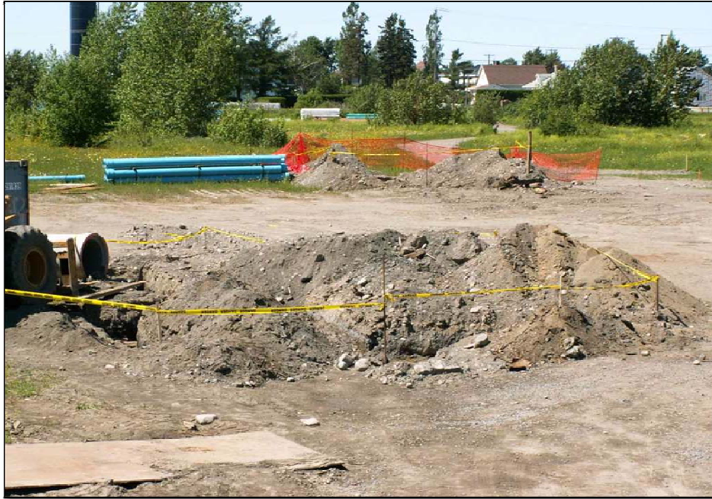
Photo 6 Route 234, site DdEa-4 : sous-opérations 1W et 1Q, partie nord, vue générale à partir du km 0+834, direction nord-nord-ouest (PATR06N03-157)
