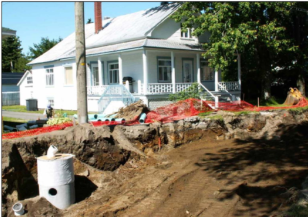
Photo 2 Secteur 4 (rue de l'Église) : maison au n° civique 29, rue de l'Église, direction ouest (PATR07N05-008)
