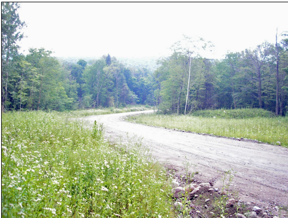
Photo 1 Aires travaillées mécaniquement de chaque côté de la route et monticule de remblai, direction ouest
