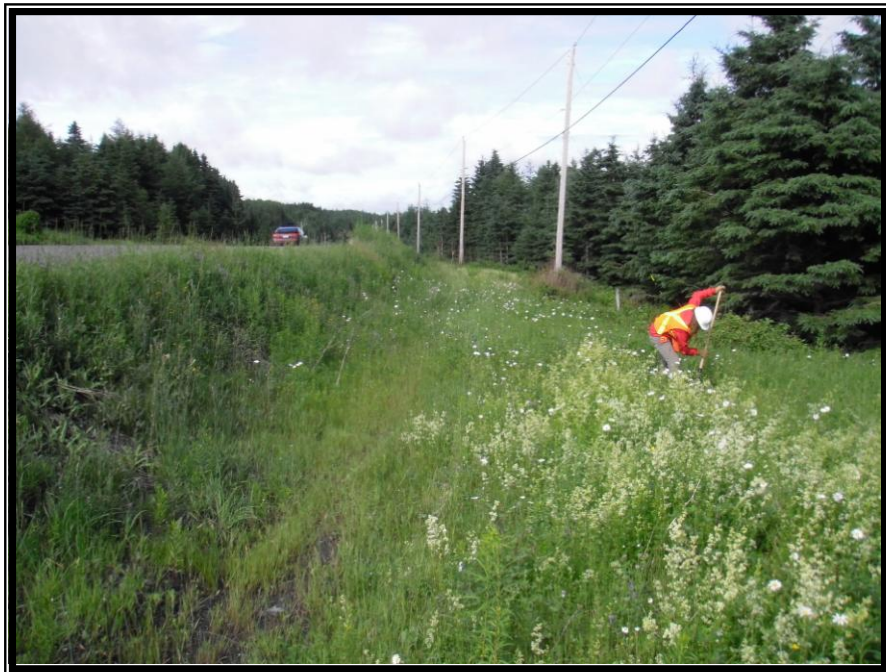
Photo 13 Vue générale de l'emprise, projet n° 154-90-0093, côté sud-est de la route 132, direction est (DUCD-09-0093-3)
