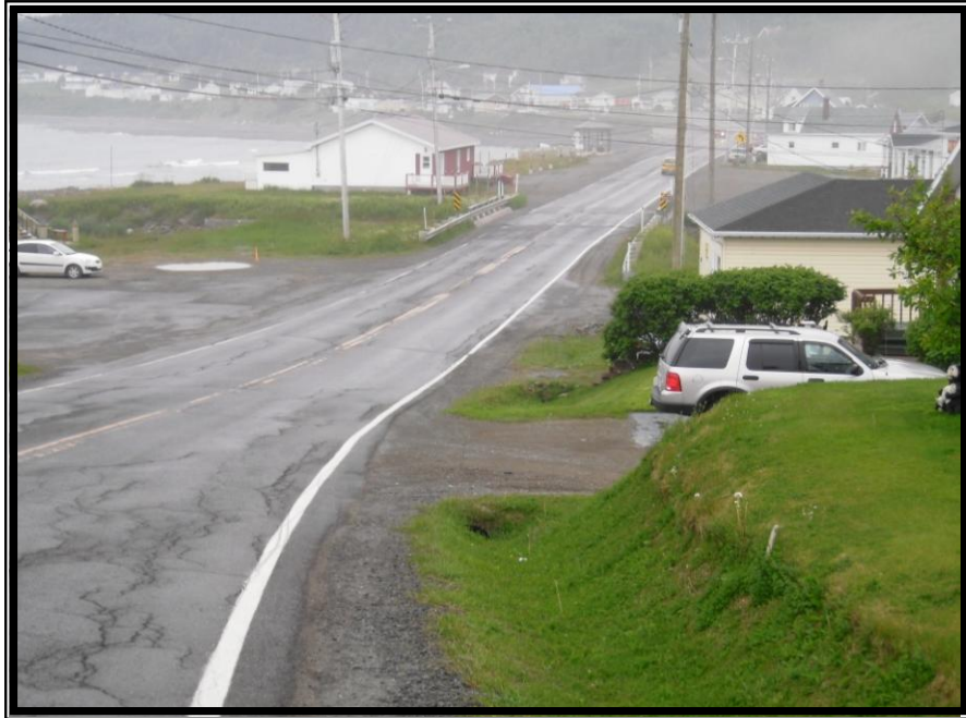
Figure 5 Vue générale de l'emprise et du pont de la rivière Grand-Cloridorme, projet n° 154-02-0027, km 8+850, route 132, direction sud-sud-est (DUCD-09-0027-15)
