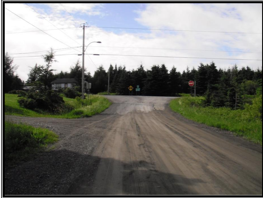
Photo 14 Vue générale de l'intersection de la route Paradis et de la route 132, direction nord (DUCD-09-0093-6)
