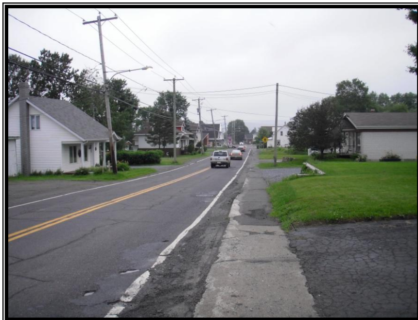
Photo 4 Vue générale du côté ouest de l'emprise, à partir du no. civique 121, route 289, direction sud (DUCD-09-0897-7)
