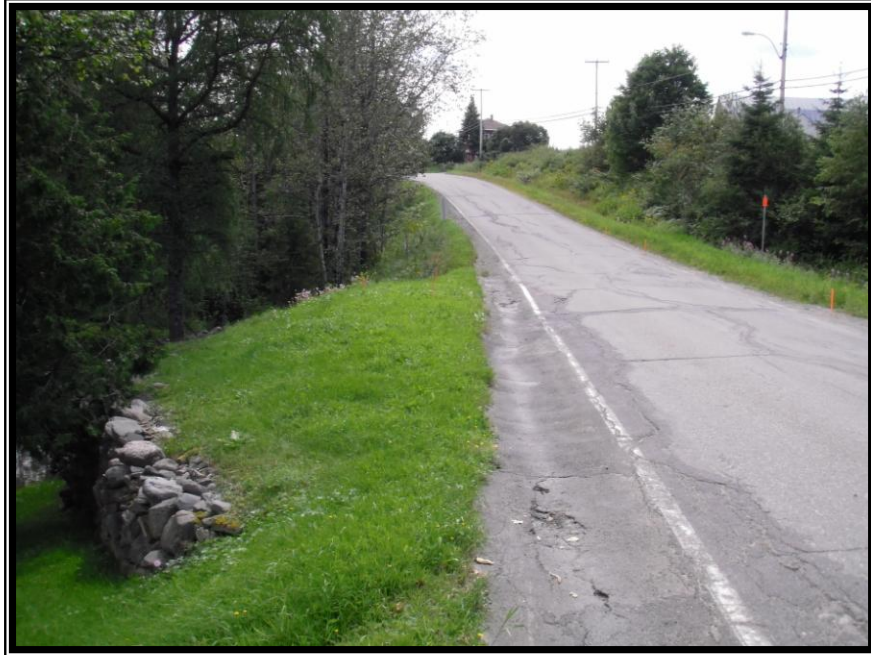
Photo 31 Ponceau et empierrement, km 1+080, côté sud de la rue Principale à Saint-Eusèbe, direction sud (DUCD-09-0170-1)
