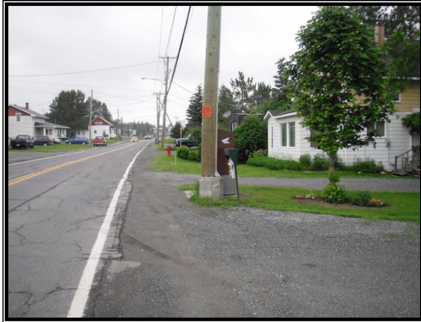
Photo 3 Vue générale du côté est de l'emprise, à partir du no. civique 121, route 289, direction sud (DUCD-09-0897-4)
