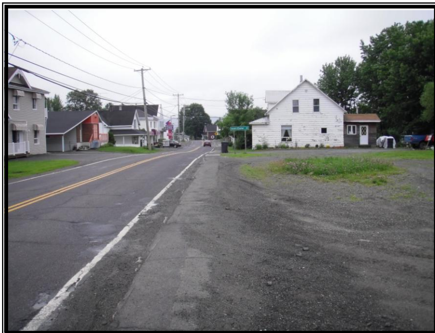
Photo 2 Vue générale du côté est de l'emprise, à partir du no. civique 113, route 289, direction sud (DUCD-09-0897-8)
