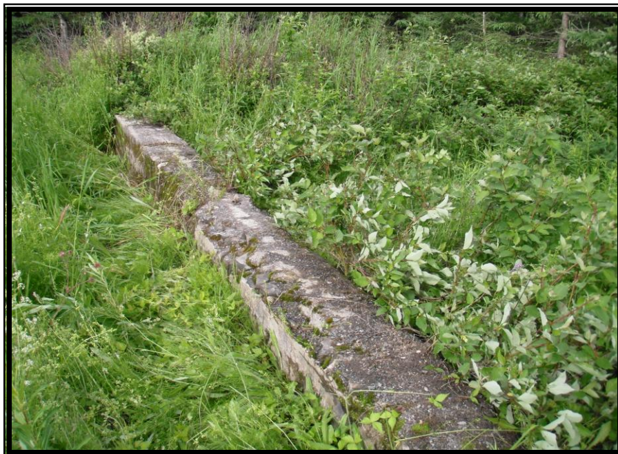
Photo 16 Mur nord, fondation en béton d'une ancienne école de rang, au sud de la route 132 et à l'est de la route Paradis, direction nord-est (DUCD-09-0093-10)
