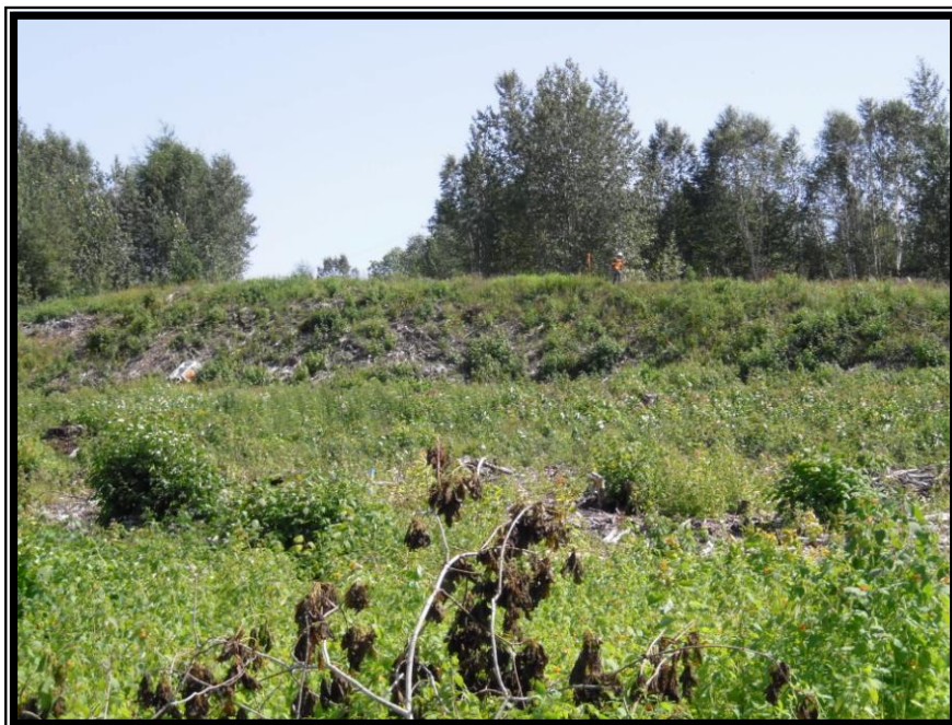
Photo 21 Remblai, secteur sud-ouest de l'emprise de l'échangeur de la Station, direction sud-ouest (DUCD-09-0100-16)
