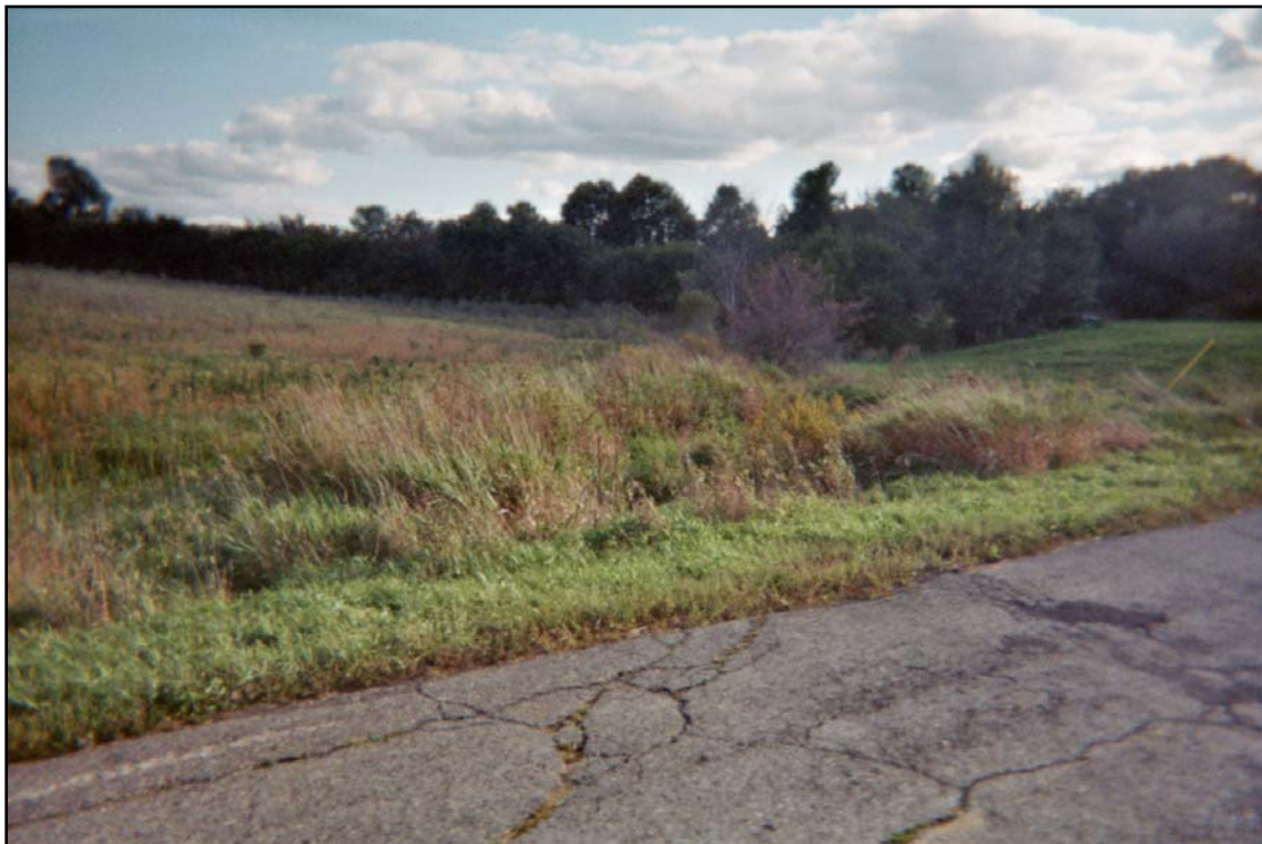
Photo 5 : Endroit rocailleux, route 203, direction ouest (154-05-0736-08-NUM1-4)
