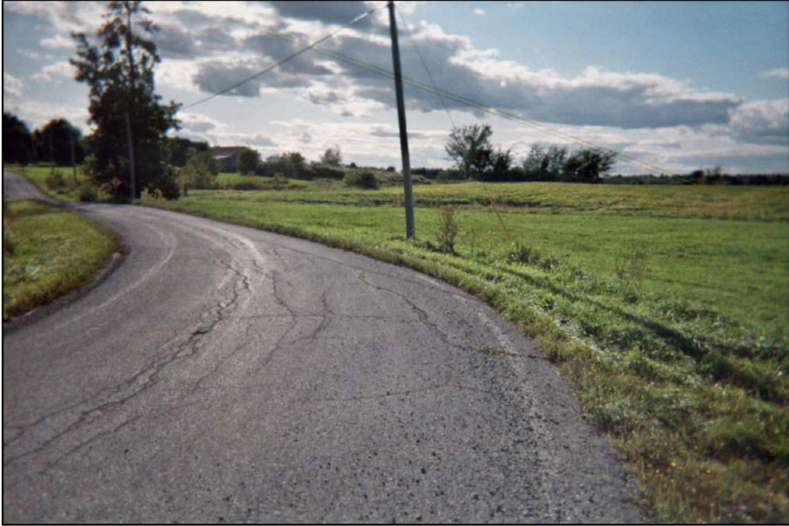
Photo 4 : Terrain vacant sur lequel une maison et un garage ont été démolis, route 203, direction est (154-05-0736-08-NUM1-2)
