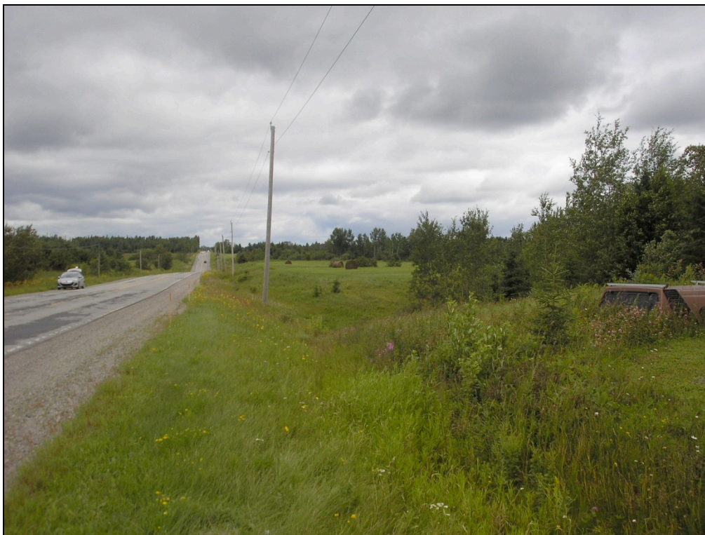
Photo 7 Secteur nord-ouest, vue générale, direction nord-ouest
