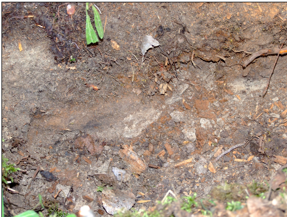
Photo 14 Ponceau 1+904, stratigraphie type, portion sud-est de la route, paroi nord, direction nord
