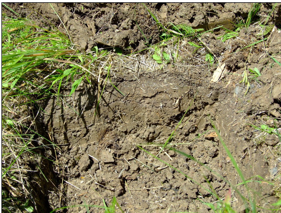
Photo 22 Ponceau P-12115, stratigraphie type, portion nord-ouest, paroi nord, direction nord
