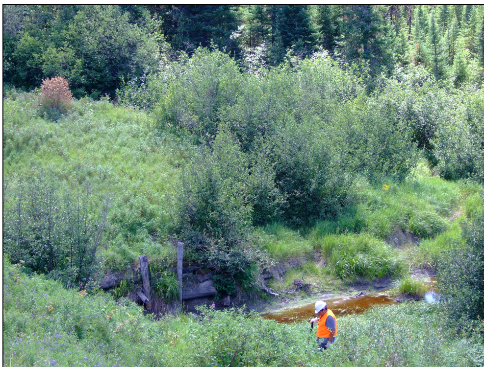
Photo 24 Ponceau P-12115, vue générale, portion sud-ouest de la zone, direction sud
