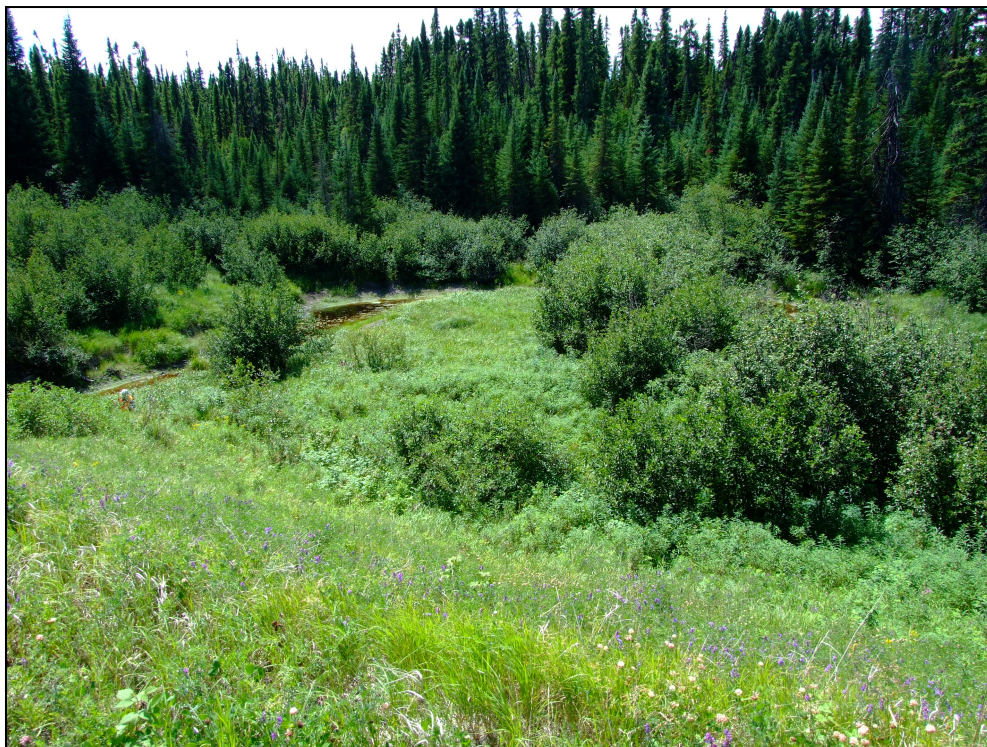
Photo 21 Ponceau P-12115, vue générale, terrasse, portion nord-ouest de la zone, direction sud-ouest
