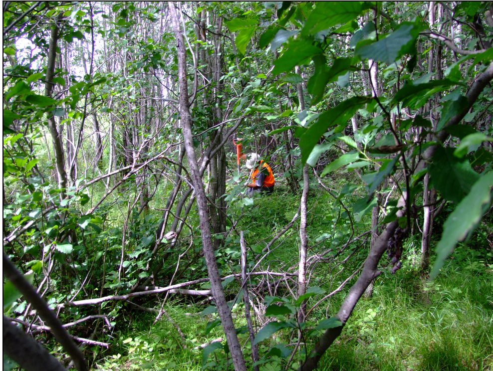
Photo 10 Ponceau 1+904, Glenn Polson à l'œuvre, portion nord-est, direction nord
