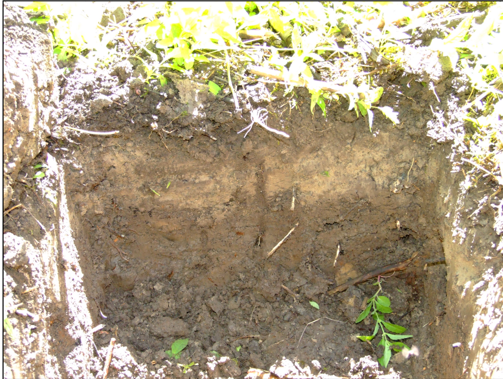
Photo 18 Ponceau P-12113, stratigraphie type, portion sud-est, paroi sud, direction sud
