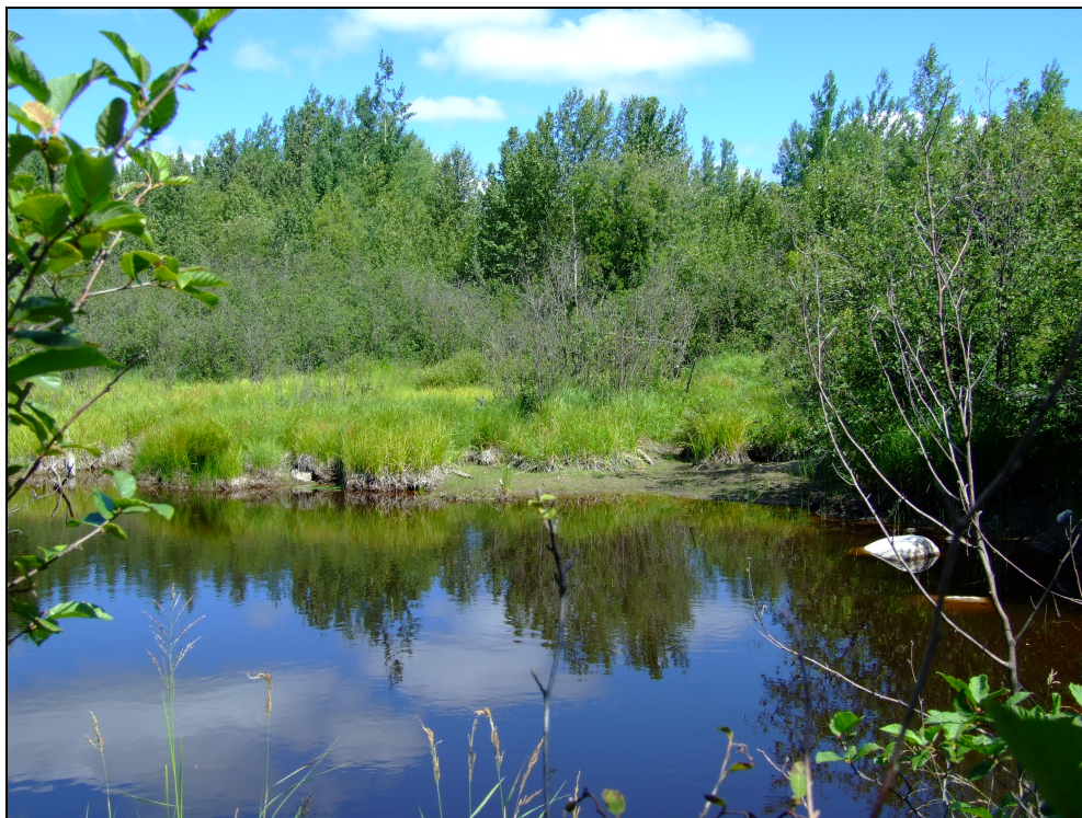
Photo 15 Ponceau P-12113, portion nord-ouest, direction nord
