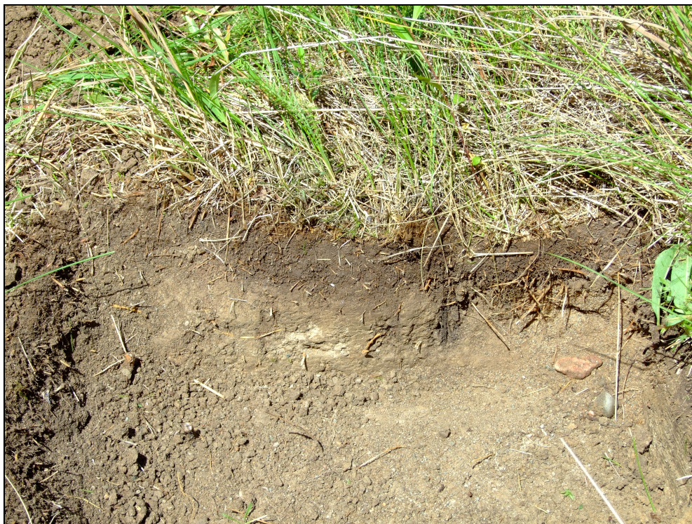
Photo 25 Ponceau P-12115, stratigraphie terre, portion sud-ouest, paroi nord, direction nord
