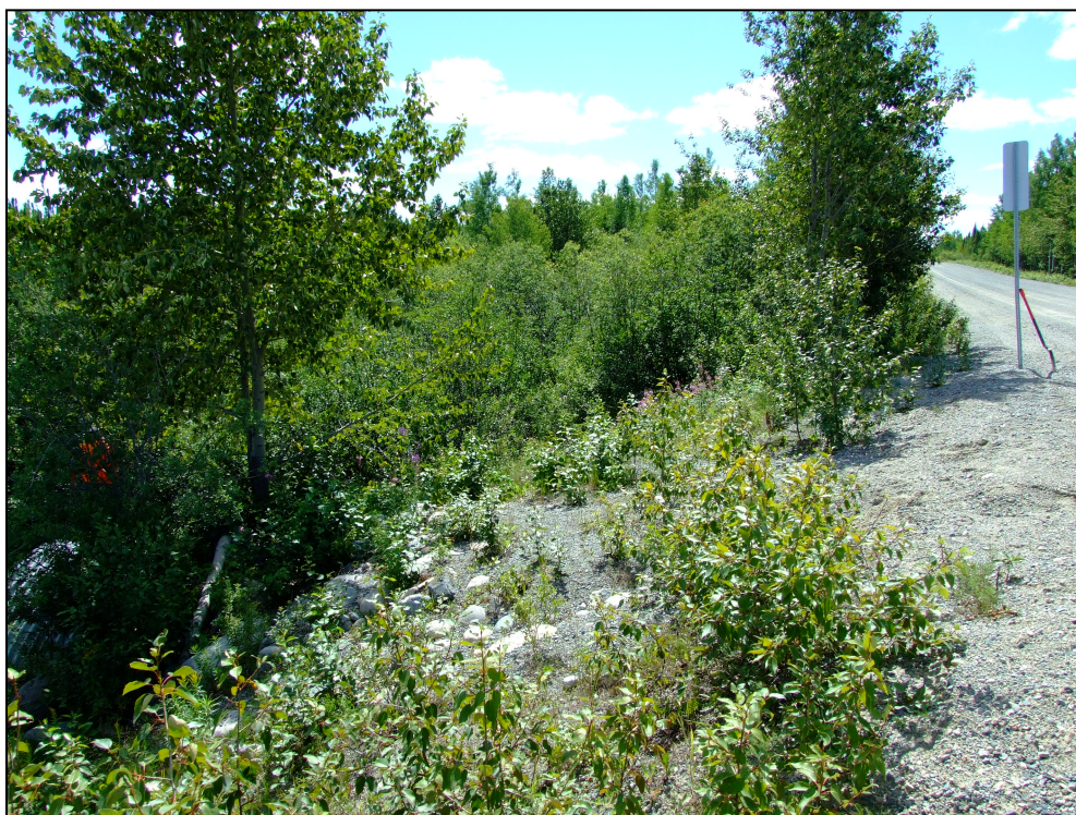
Photo 16 Ponceau P-12113, vue générale, portion nord-est, direction sud
