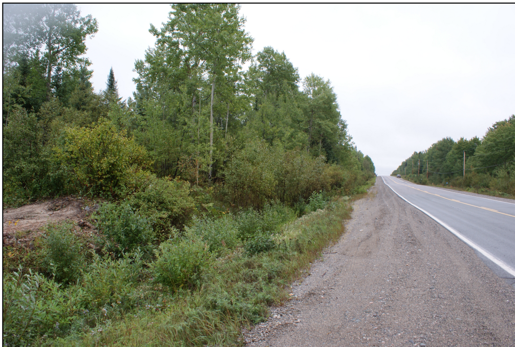
Photo 32 Chainage 5+660, vue générale de l'emprise nord, direction est
