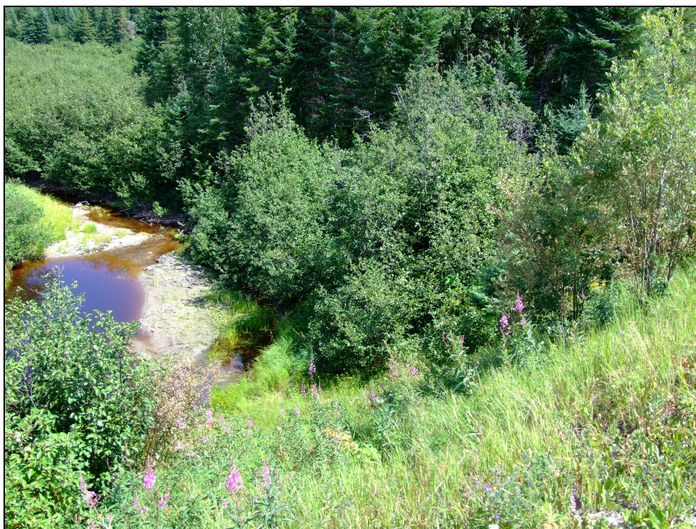
Photo 26 Ponceau P-12115, vue générale, portion sud-est de la zone, direction sud-est
