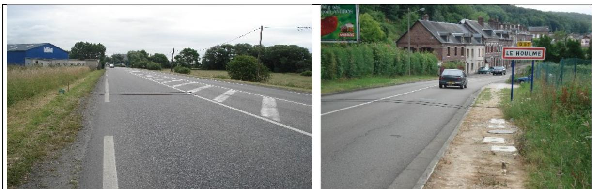
Figure 19. Exemple d'installation de tubes. Installation pour comptage et relevé de vitesse. À gauche, sur une seule voie, à droite sur les deux voies.
