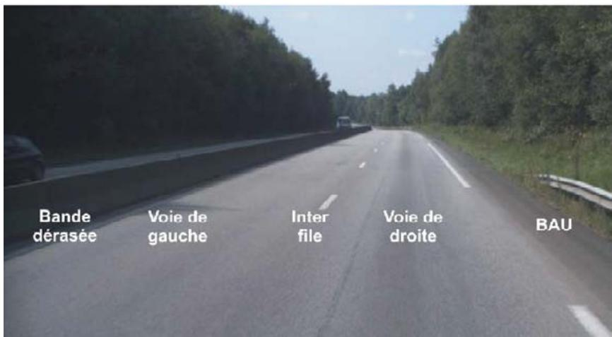
Figure 9. Photo de la section de l'A28 2x2 voies (PR93-621, 76) avec les positions possibles.
