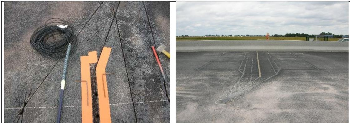
Figure 24. Photographies d'un système piézoélectrique. À gauche, photo d'un câble piézoélectrique avant installation. À droite, photo d'un système piézoélectrique après installation (au centre des deux boucles inductives).
