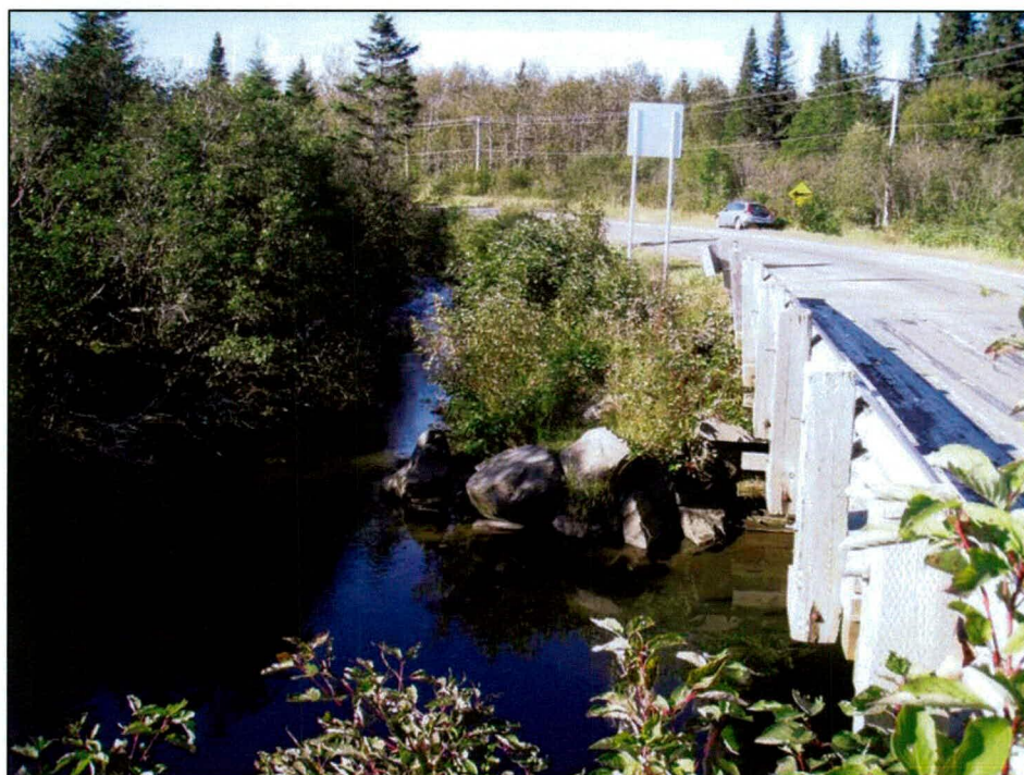
Photo 23 Projet no 154-01-0021 - Approche nord-ouest du pont avec empierrement, vers le nord-ouest (Gaspé_6)
