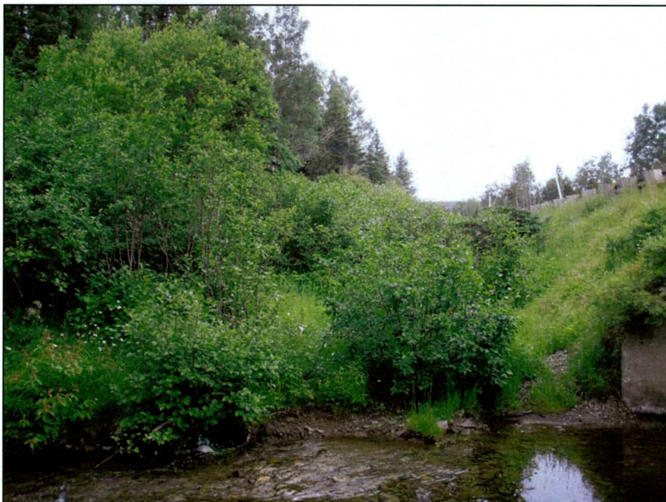
Photo 8 Projet n°154-08-1307 - Vue de l'approche sud-ouest du pont n° P-12189, vers le nord-ouest (Collines-du-Basque_3)
