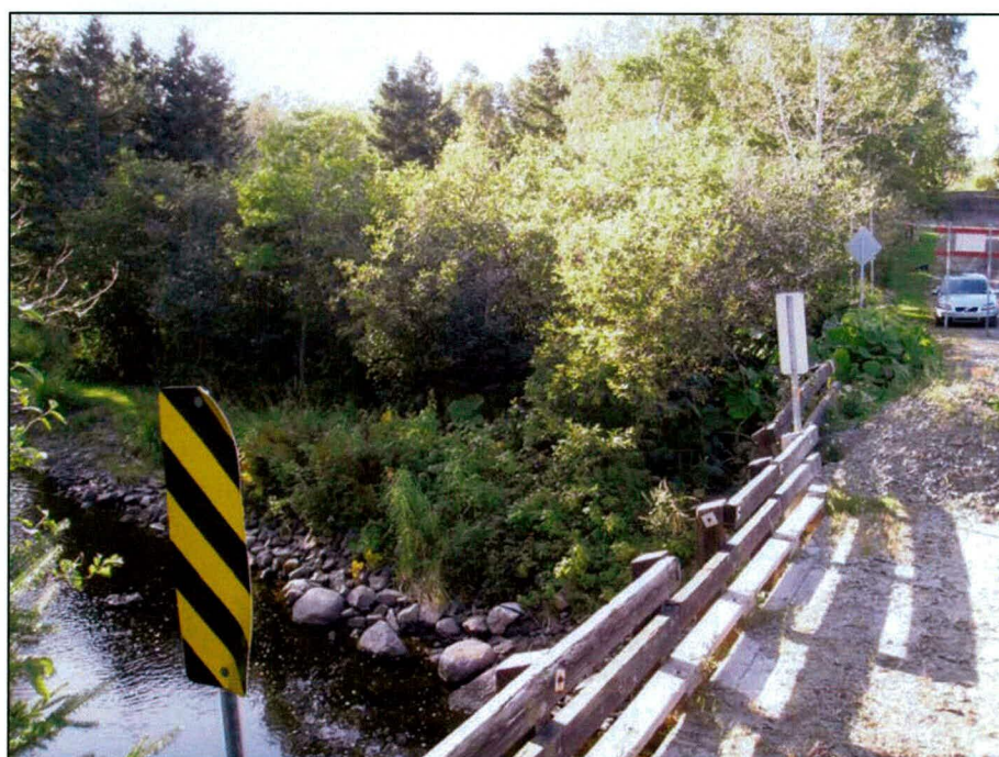
Photo 18 Projet n° 154-00-0182 - Vue du côté nord-ouest du pont montrant l'empierrement le long de la rive nord de la rivière du Bic, vers l'ouest (Saint-Fabien_8)
