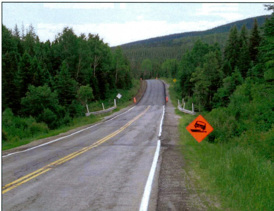
Photo 7 Projet n° 154-08-1307 - Vue d'ensemble de la municipalité de Collines-du-Basque, route 198, reconstruction du point n° P-12189, vers du projet n° 154-08-1307, vers l'est (Collines-du-Basque_7)
