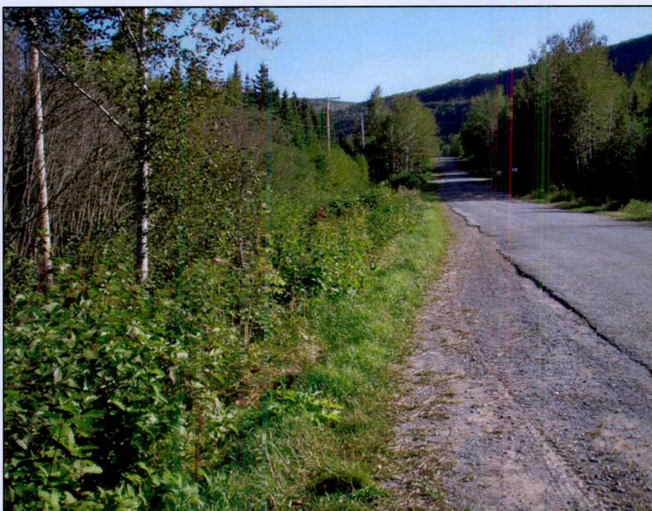
Photo 24 Projet n° 154-01-0021 - Limite sud-est du projet n° 154-01-0021, ville de Gaspé, chemin Pointe-Navarre, reconstruction du point n° P-2309, vers le sud-est (Gaspé_8)
