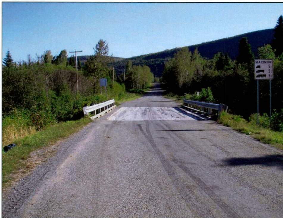
Photo 22 Projet n° 154-01-0021 - Vue d'ensemble du pont n° P-2809, vers le sud (Gaspé_2)
