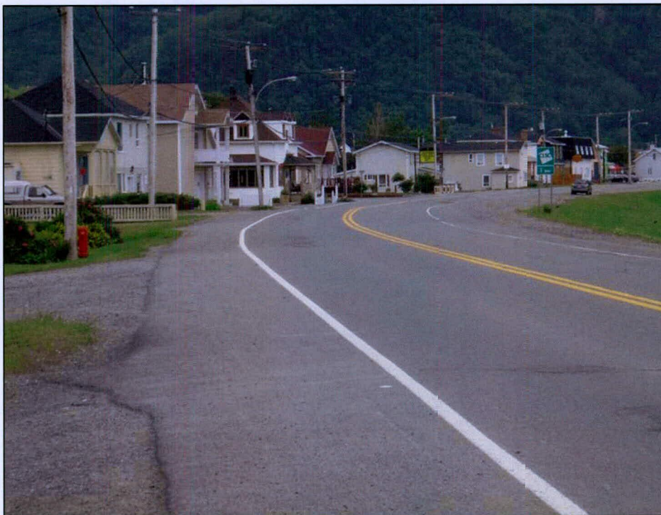
Photo 10 Projet n° 154-07-2246 - Vue générale de l'emprise du projet à partir de l'extrémité est du projet, vers le sud-ouest (Saint-Maxime-du-Mont-Louis_14)
