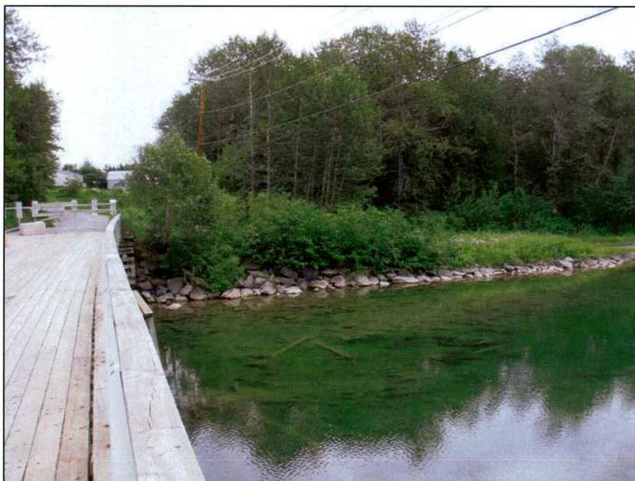
Photo 4 Projet n° 154-06-0644 - Vue de la rive sud-est de la rivière du Petit-Pabos, vers le sud-est (Chandler_18)
