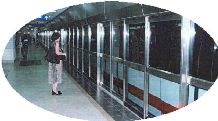
FIGURE 20 - Exemple d'un système de portes palières
