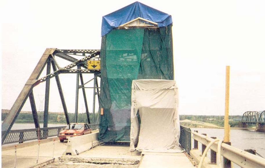
Installation type pour des travaux au-dessus du tablier. Des bâches filtrantes entourent complètement l'aire des travaux pour empêcher les produits de décapage d'être rejetés dans le cours d'eau sous-jacent.
