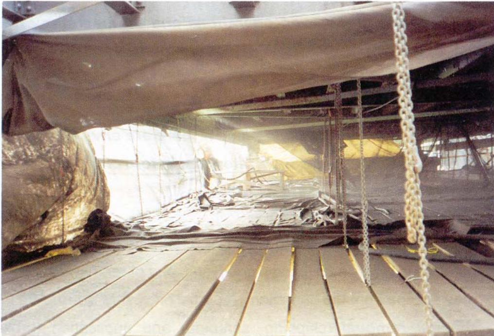
Installation type pour des travaux sous le tablier. Remarquer la présence de géotextile au-dessus de l'échafaudage pour recueillir les produits abrasifs usés.
