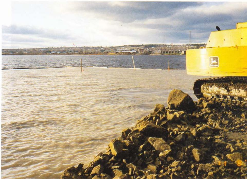
Nappe filtrante placée dans un cours d'eau pour retenir le limon provenant des activités de terrassement et pour empêcher qu'il ne soit emporté en aval. Remarquer que la nappe filtrante est placée de telle façon que si des eaux de ruissellement chargées de limon provenant du chantier pénètrent dans le cours d'eau, elles entreront dans la zone de confinement.
