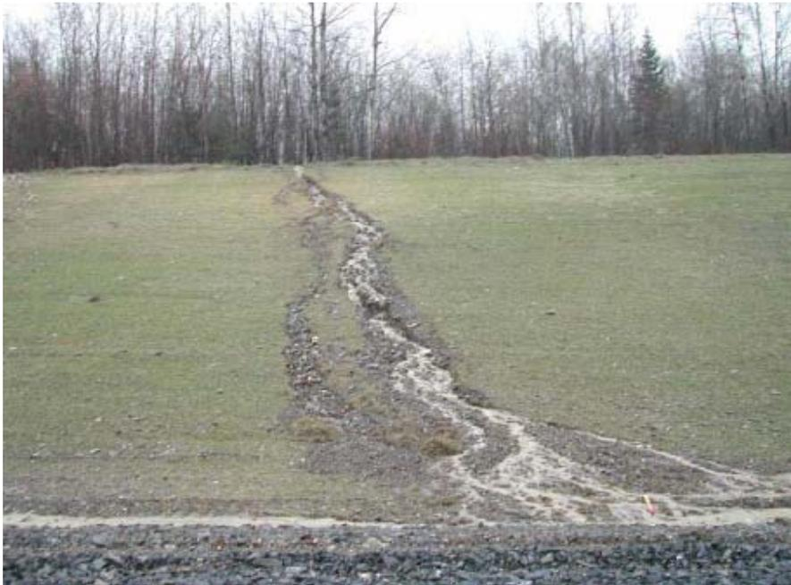
Cette pente nécessite des canaux sur appuis (tuyaux de drainage inclinés) pour permettre l'écoulement de l'eau du haut de la pente vers le fossé.
