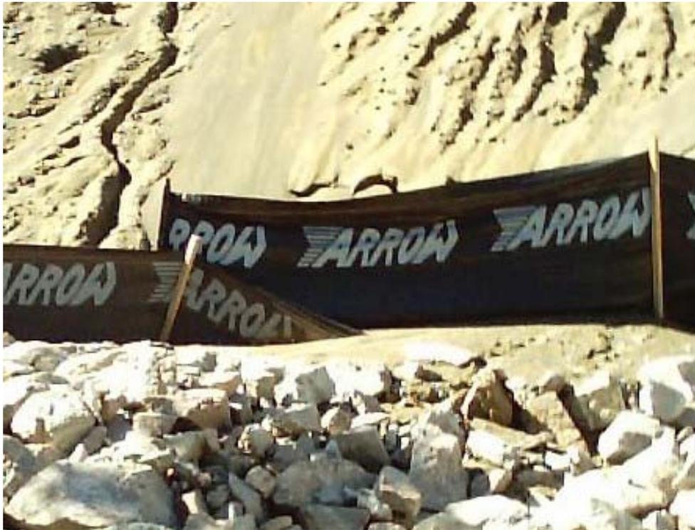
Sédiments contournant l'extrémité d'une barrière.
