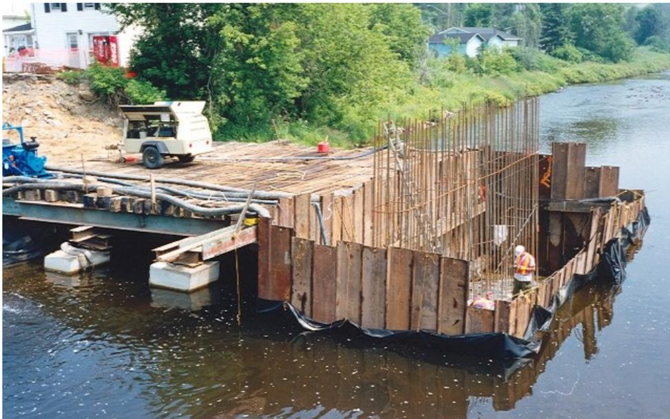
Un batardeau-palplanches et une nappe filtrante à une pile de pont pour isoler l'aire des travaux du cours d'eau.
