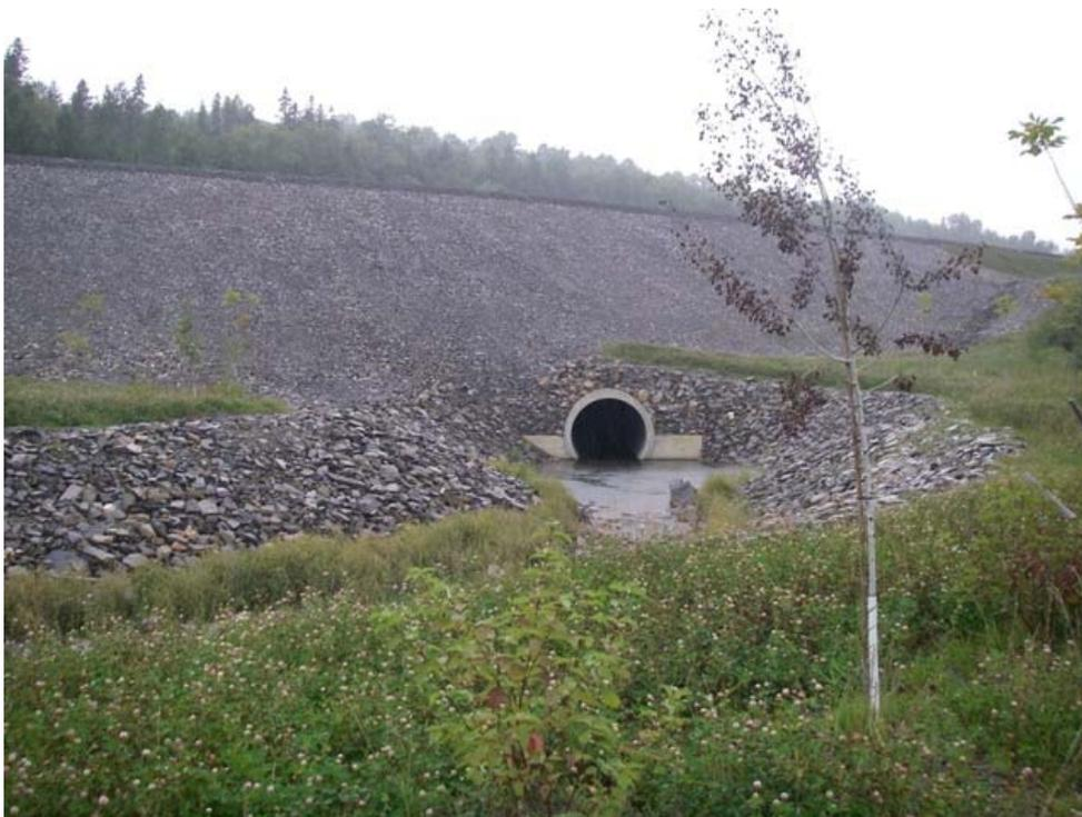
Stabilisation permanente du chantier, y compris la protection contre l'érosion des talus en remblai avant
