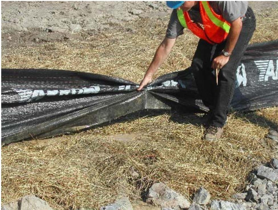
Installation inappropriée d'une barrière de retenue des sédiments
