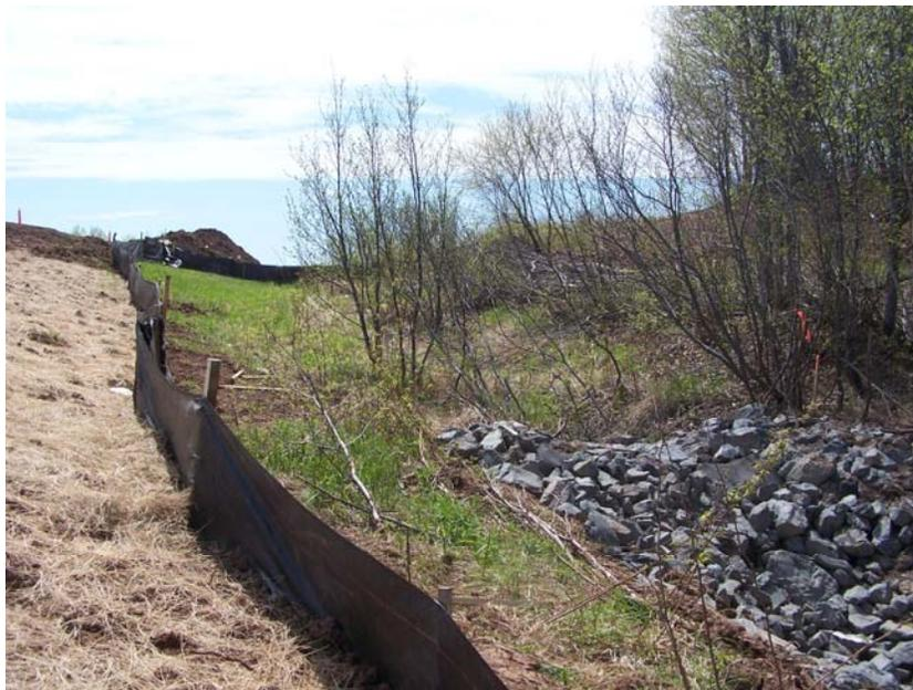
Installation appropriée d'une barrière de retenue des sédiments au pied d'un remblai.
