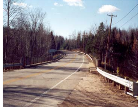
Photo10 : Pont direction ouest
