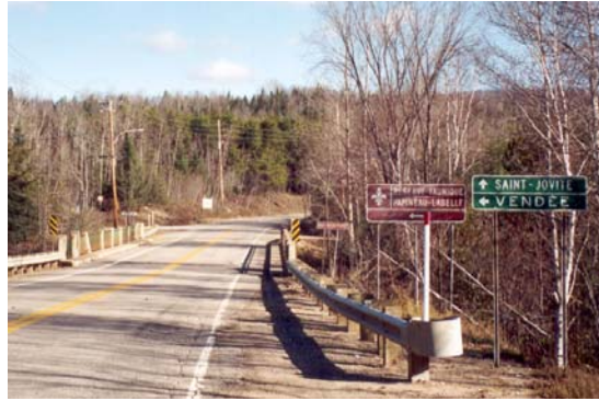
Photo 9 : Pont direction est
