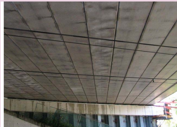
Sous-face du tablier de l'ouvrage
