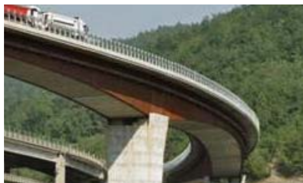
Un exemple récent de caisson à âmes métalliques planes, le viaduc de Roccaprebalza, en Italie
