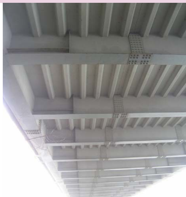
Figure 1 : dalle orthotrope, avec augets discontinus
