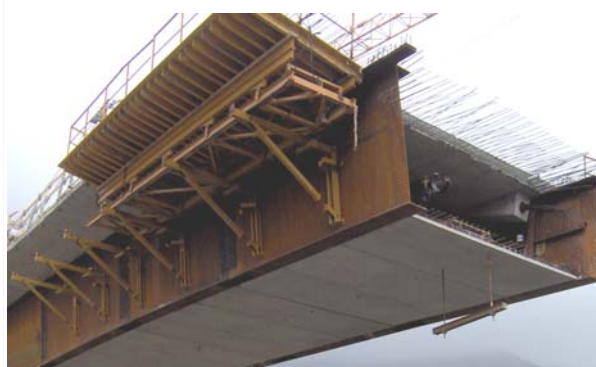
Un exemple récent de caisson à âmes métalliques planes, le viaduc de Roccaprebalza, en Italie
