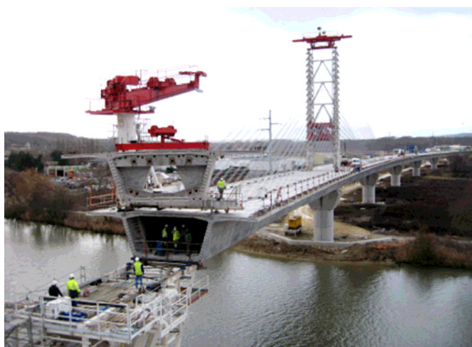
Le viaduc de Compiègne
