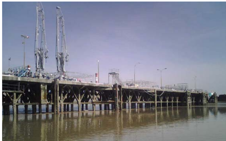
Figure 3 : le poste pétrolier
