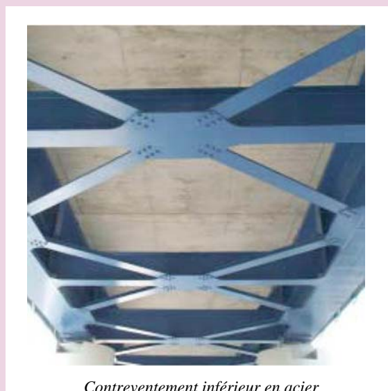
Contreventement inférieur en acier
