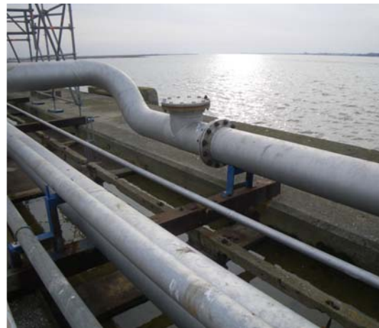
Figure 4 : encombrement des canalisations au dessus de la dalle
