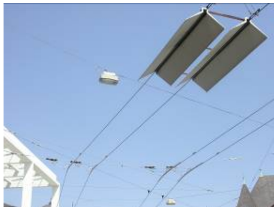
FIGURE 3: ÉLÉMENTS SERVANT À ALIGNER LES PERCHES SUR LES CATÉNAIRES
