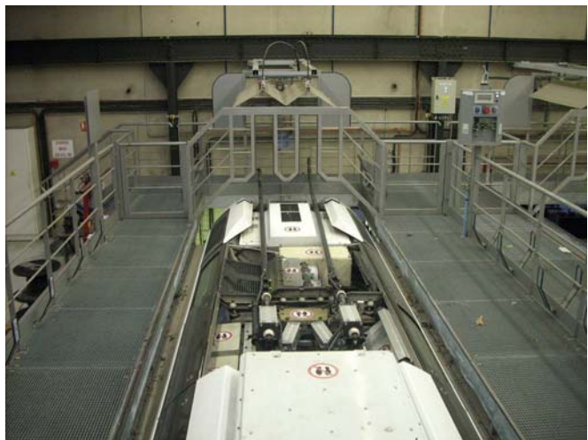
FIGURE 26: PHOTO D'UNE ÉLECTRIFICATION PARTIELLE DE LA BAIE DE TRAVAIL
