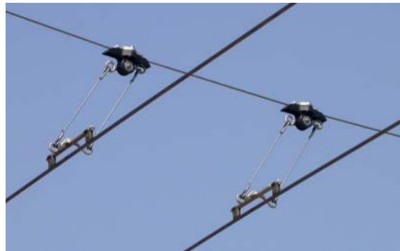
FIGURE 24: SYSTÈME DE SUSPENSION ÉLASTIQUE
