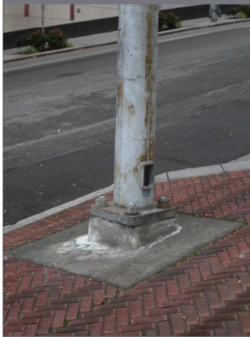
FIGURE 18: INSTALLATION D'UN MASSIF ET POTEAU
