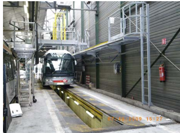
FIGURE 18: POSITIONNEMENT DE LA PASSERELLE
