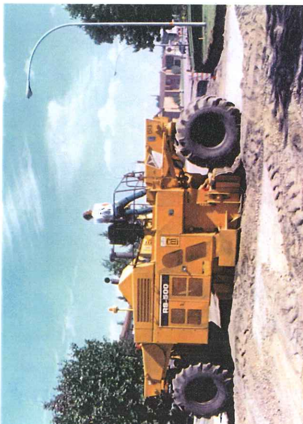
Figure 3.3-4 Planage de la surépaisseur du revêtement à l'aide d'un planeur
