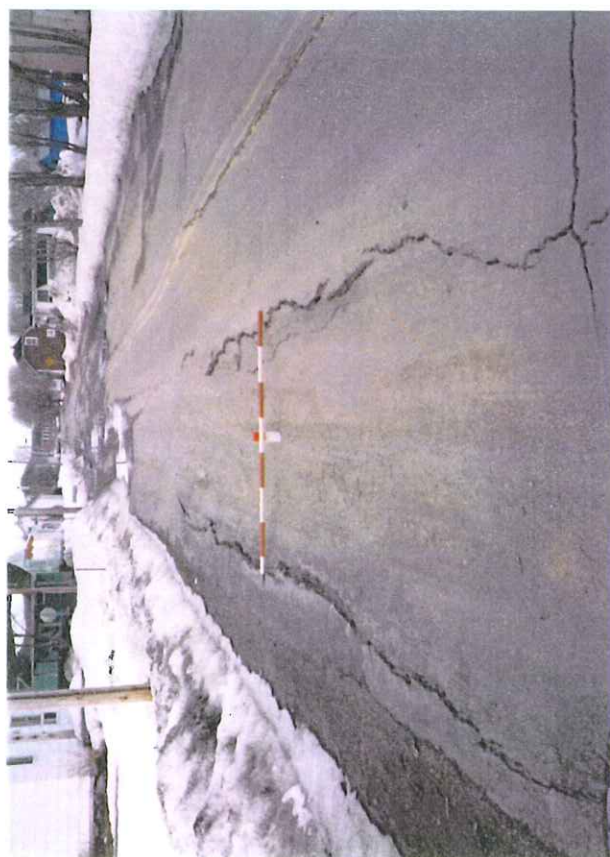
Figure 4.3-1 Soulèvement au gel
