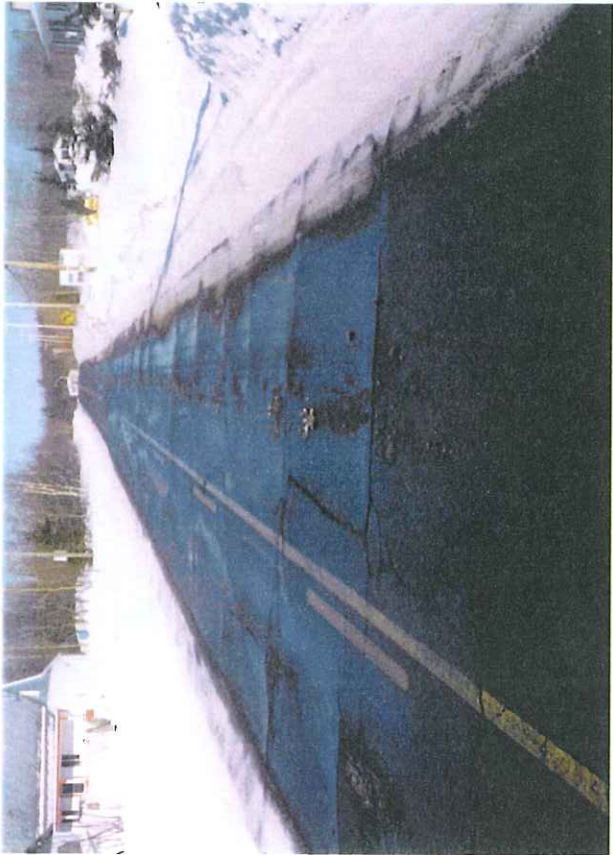
Figure 4.2-4 Fissures transversales soulevées
