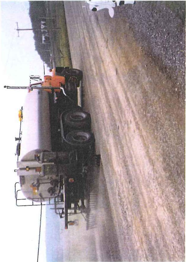
Figure 3.3-10 Stabilisation précédée de la citerne de liants
