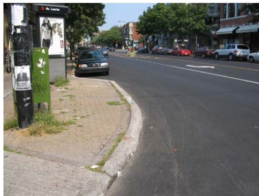
Saillie de trottoir permettant de dégager l'intervisibilité piéton-automobiliste
