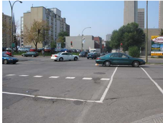
Absence de feux piétons - boulevard de 2 x 4 voies à fort débit de circulation
