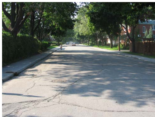
Absence d'aménagement d'apaisement de la circulation dans une rue large à sens unique d'un quartier résidentiel
