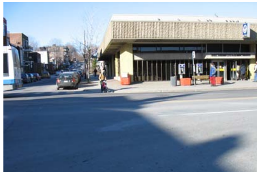
Absence d'aménagement particulier vis-à-vis de deux édifices de métro de part et d'autre de la rue
