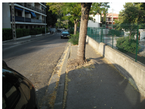
Arbres implantés au milieu d'un trottoir (Source : Cete Méditerranée)
