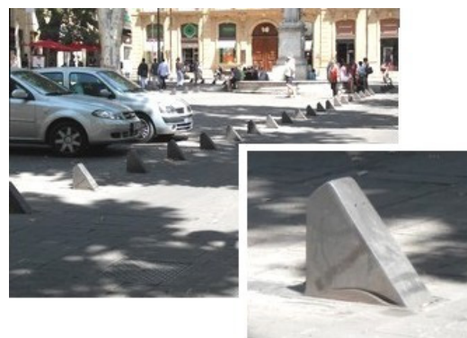
Mobilier anti-stationnement non-conforme à la réglementation accessibilité (abaque de détection) (Aix en Provence)
