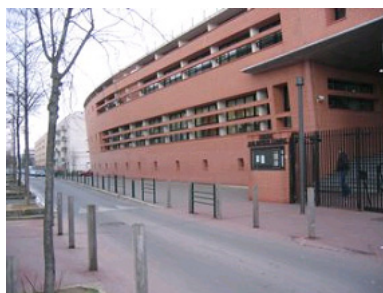
Rue avec un trottoir dédié au cheminement et un trottoir « sacrifié » à l'implantation des arbres et candélabres (Source : Cete Méditerranée)
