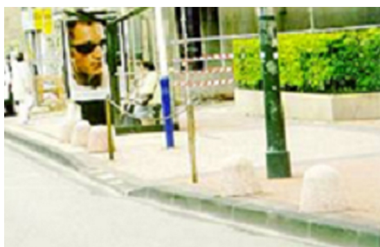
Borne anti-stationnement peu détectable en raison d'un contraste visuel insuffisant
