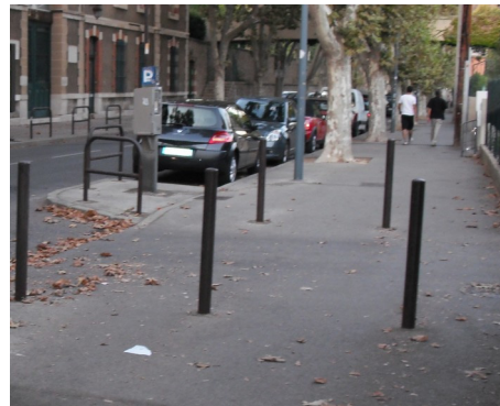
Exemple de contraste insuffisant (potelets noirs sur fond gris) (Source : Cete Méditerranée)
