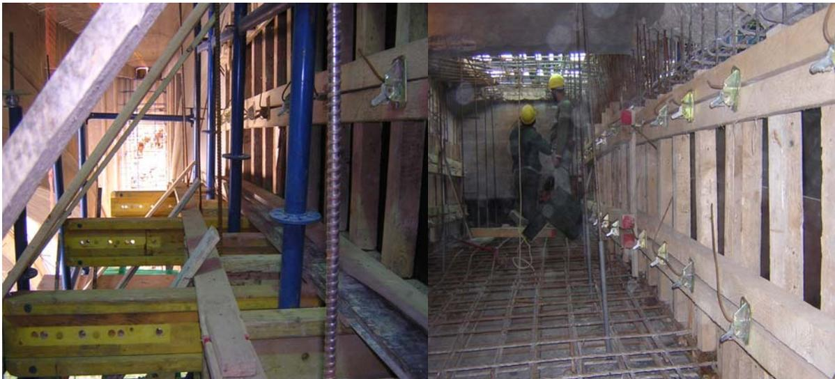
Photo 7 : Mise en place du coffrage
