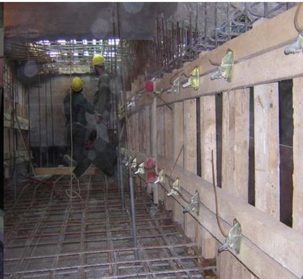
Photo 8 : Mise en place du ferrailage à la clé de l'arc 2
