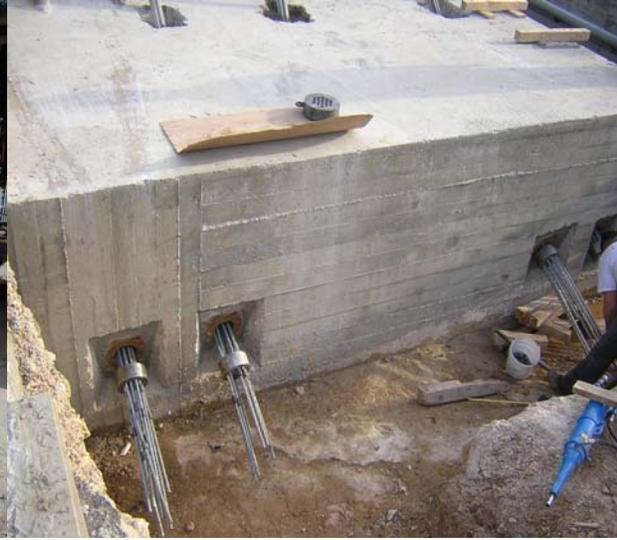
Photo 6 : Massif d'ancrage arrière
