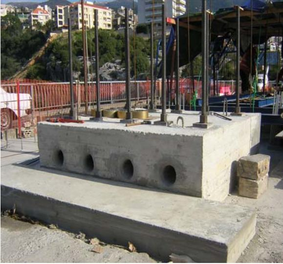
Photo 5 : Massif d'ancrage du tablier
