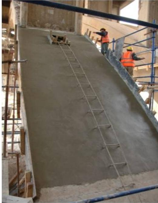
Photo 13 : Bétonnage du hourdis supérieur de l'arc 3
