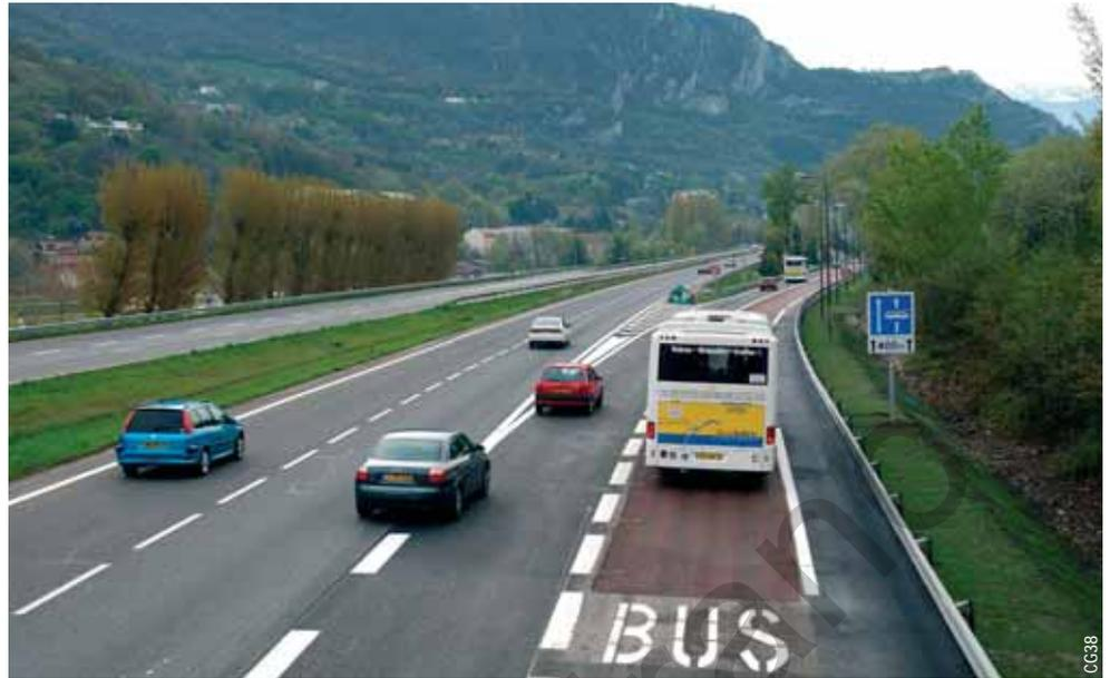
d'échanges composé de nombreuses lignes d'autobus et de deux lignes de métro. Sur les douze premiers kilomètres situés en périphérie, le site propre (sans station) comporte deux files réversibles réservées aux autobus et aux covoitureurs. La section la plus proche du centre, d'environ 4 km, ne comporte qu'une seule file réversible, strictement réservée aux autobus.
