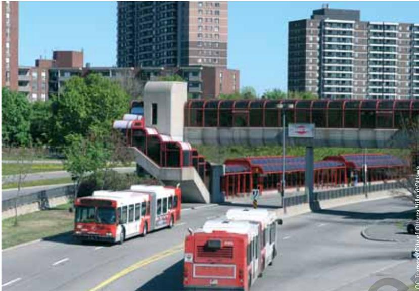
À Ottawa, l'accès aux stations du réseau Transitway se fait par des ouvrages d'art aériens. Les sites propres comportent 2x2 voies, permettant ainsi la desserte de bus express et de services omnibus.
