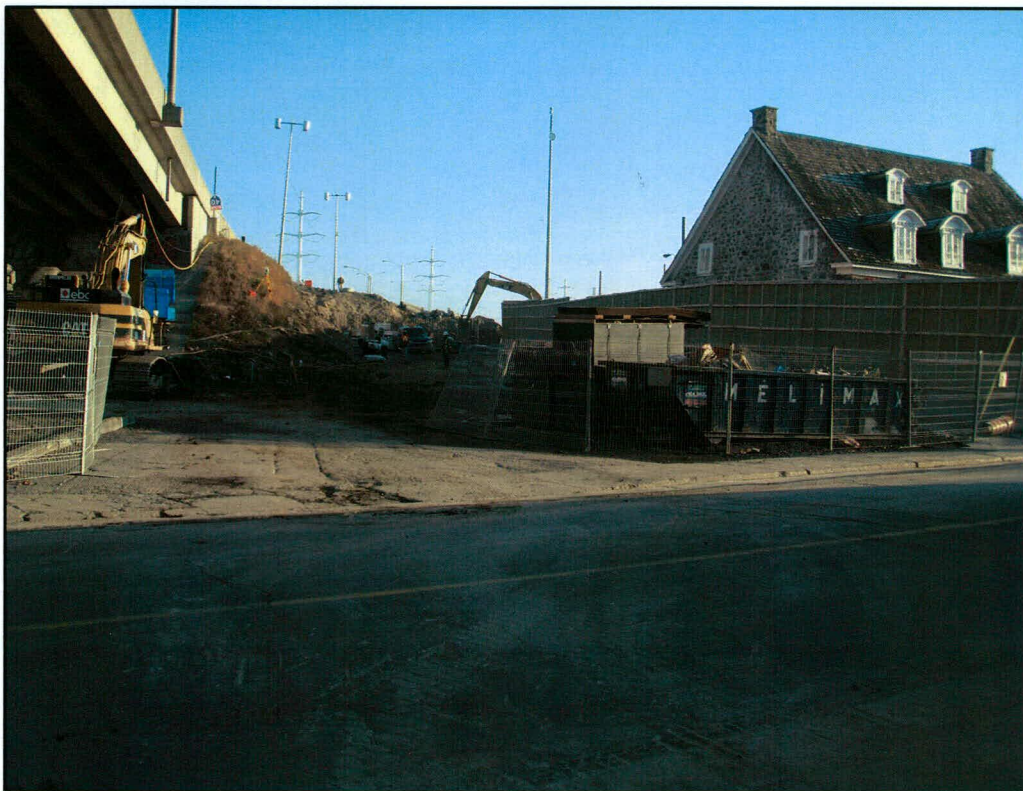
Photo 2 : Emplacement prévu du pilier n° 9 – Sous-opération 1E – Maison Simon-Frazer (à droite) – Direction nord (154-99-0880-07-NUM2-10)
