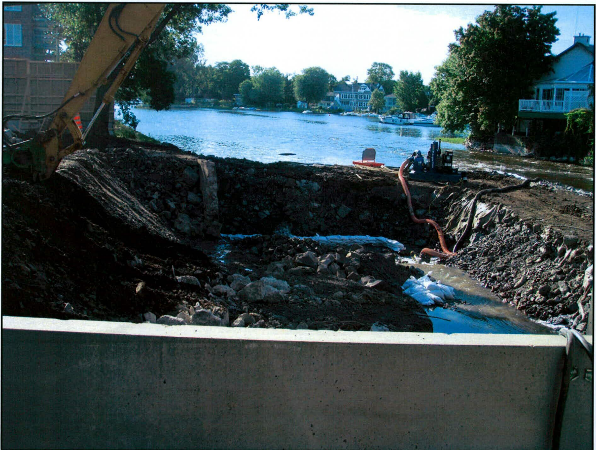
Photo 1 : Excavation et batardeau – Pilier n° 3 – Sous-opération MTQ0823-1A – Direction est (154-99-0880-08-NUM2-1)
