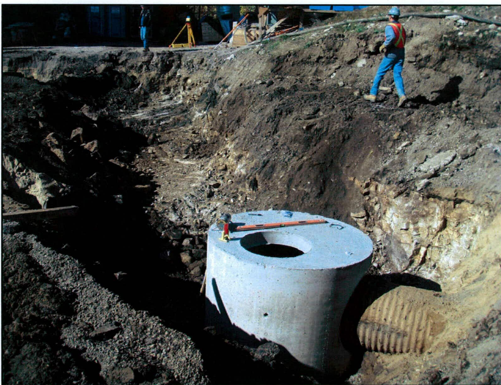
Photo 3 : Tranchée de déviation de l'égout pluvial – Direction nord-ouest (154-99-0880-07-NUM2-7)
