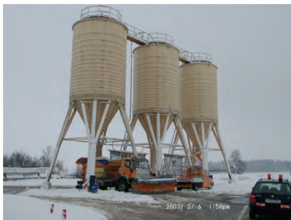
Optimisation du temps de chargement par l'utilisation de silos de stockage verticaux
