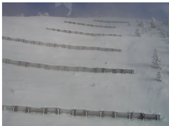
10- Barrières de protection à clais, Canal de Nicolau, El Serrat.
