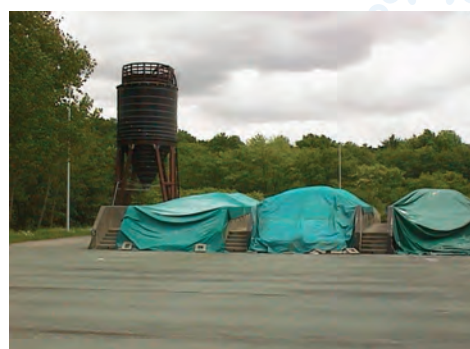
Exemple de silos à sel utilisés en Belgique
