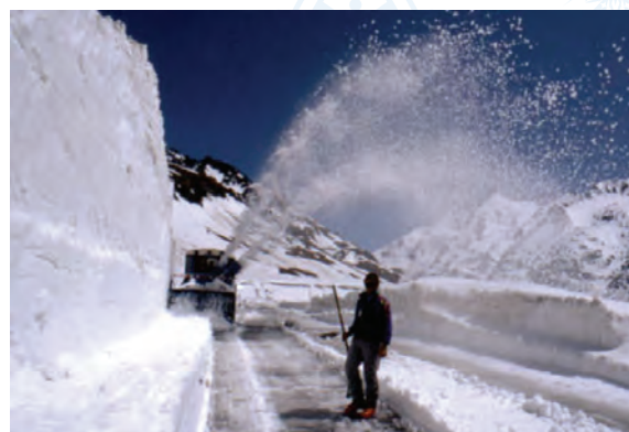
Figure 4 – Enlèvement de la neige dans le Großglockner Hochalpenstraße
