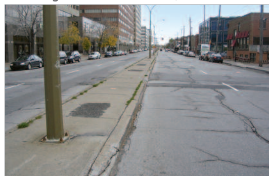
Figure 74 : Rue Chabanel, avant les travaux.
