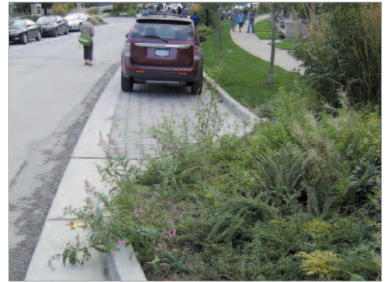
Figure 57 : Espace de stationnement minimal, en pavé perméable.
