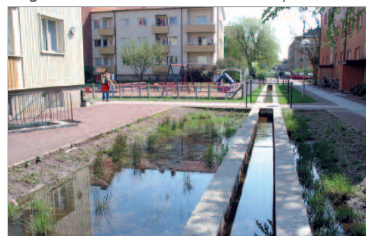
Figure 7 : Mise en valeur des eaux de pluie, Suède.
