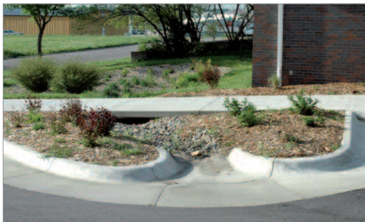
Figure 54 : Zone d'infiltration ponctuelle.
