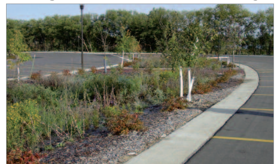
Figure 59 : Aire de stationnement aménagée.
