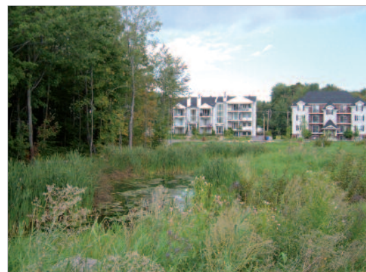
Figure 15 : Le bassin de rétention du parc Schulz, Saint-Jérôme.
