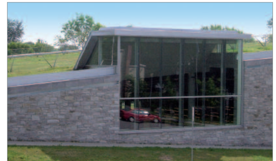
Figure 28 : Toiture de la bibliothèque de Charlesbourg, Québec.
