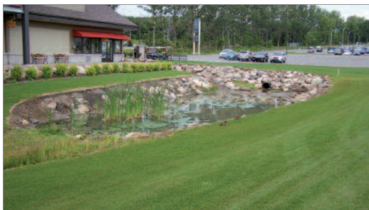
Figure 45 : Bassin dans un secteur commercial et institutionnel.
