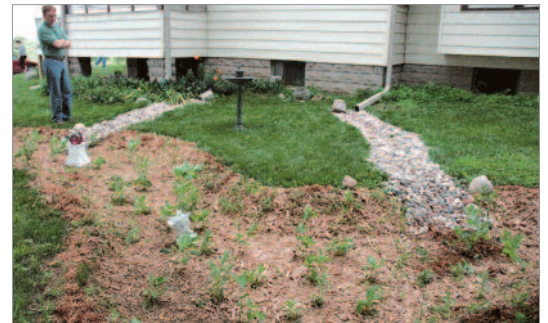
Figure 48 : Gouttières raccordées à un jardin de pluie.
