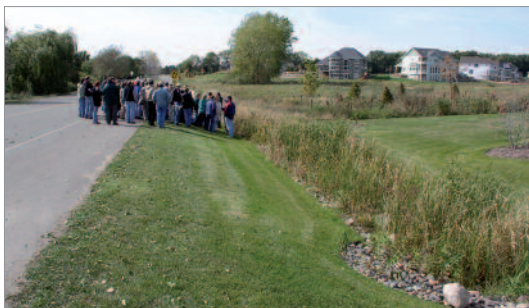
Figure 53 : Espace de rétention/infiltration le long de la rue.
