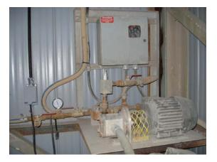
**Figure 2 – HyperTherm Dosing Pump**
