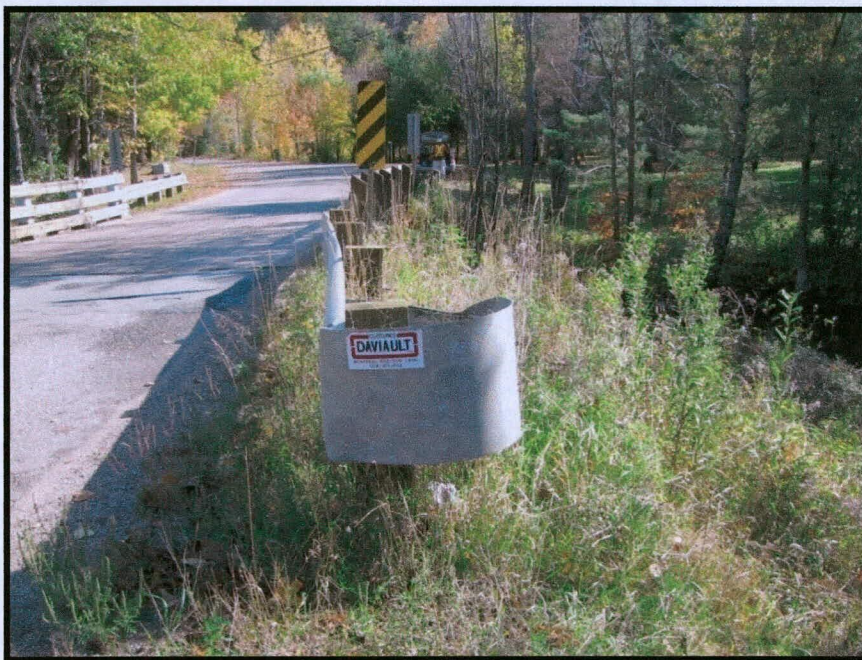
Photo 17: Projet 154-07-0130, détail de l'emprise, coté sud du pont, chemin du lac Poisson Blanc, municipalité de Denholm, direction est (MTQ-L5.44)
