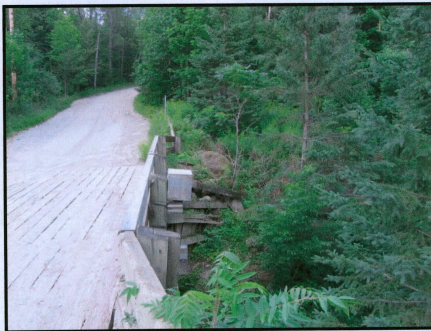
Photo 2 : Projet 154-99-1274, détail des culées et de l'emprise, chemin Sullivan, municipalité de Low, direction ouest (MTQ-L5.02)
