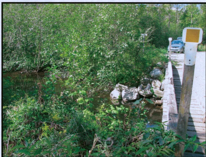
Photo 13 : Projet 154-91-2898, détail de l'emprise et de l'empierrement, coté sud du pont, chemin Fortin, municipalité de Blue Sea, direction ouest (MTQ-L5.32)
