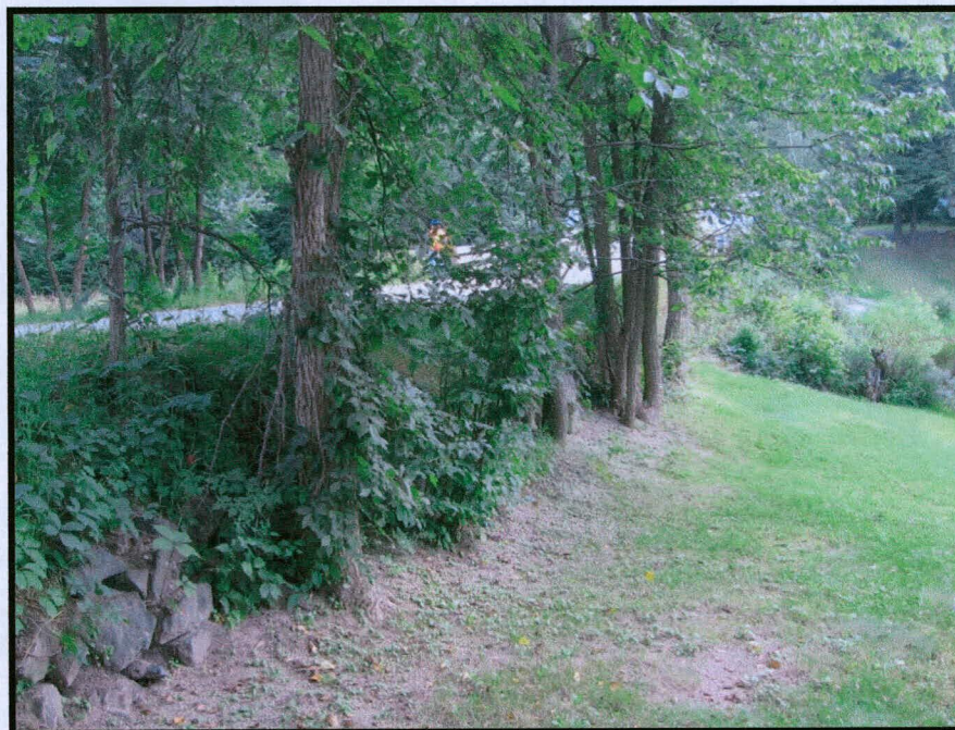
Photo 6 : Projet 154-01-1098, détail de l'emprise du côté nord-est du pont, montrant la hauteur du remblai, chemin Buckingham, municipalité de Val-des-Monts, direction sud-ouest (MTQ-L5.10)
