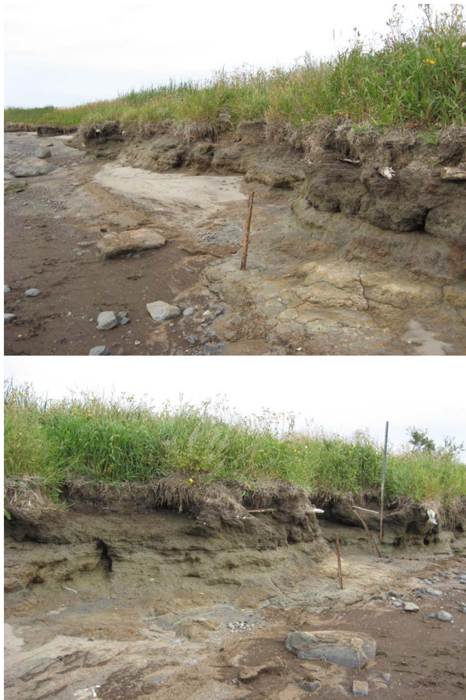
FIGURE 2 : POTEAUX DÉLIMITANT L'EMPRISE DE LA ROUTE
