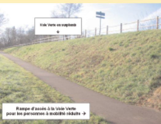
Rampe d'accès à une voie verte pour les PMR
