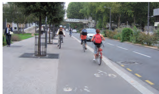
Piste contiguë à la chaussée
