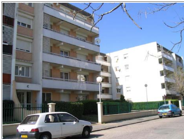
Les entrées sont laissées ouvertes Photographie : CETE SO
