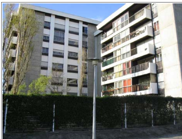
Le bailleur a souhaité améliorer la qualité visuelle de la clôture en végétalisant Photographie : CETE SO
