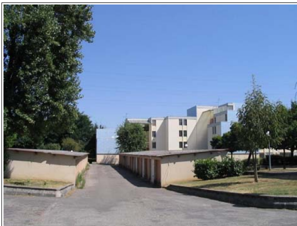
La résidence Virecourt comporte plusieurs garages fermés Photographie: CETE SO
