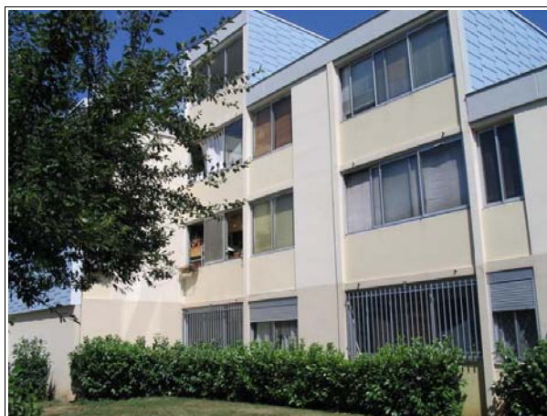
Les pieds d'immeuble avant la résidentialisation Photographie : CETE SO
