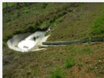
*Illustration 15 : raccordement descente d'eau vers fossé servant d'exutoire par une cuvette béton en pied. Élément technique pouvant avoir un impact paysager non négligeable (Côte de l'Ouest)*
