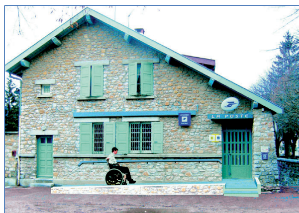
Des rampes d'accès aux bâtiments publics qui intègrent architecture et contrainte climatique locales
