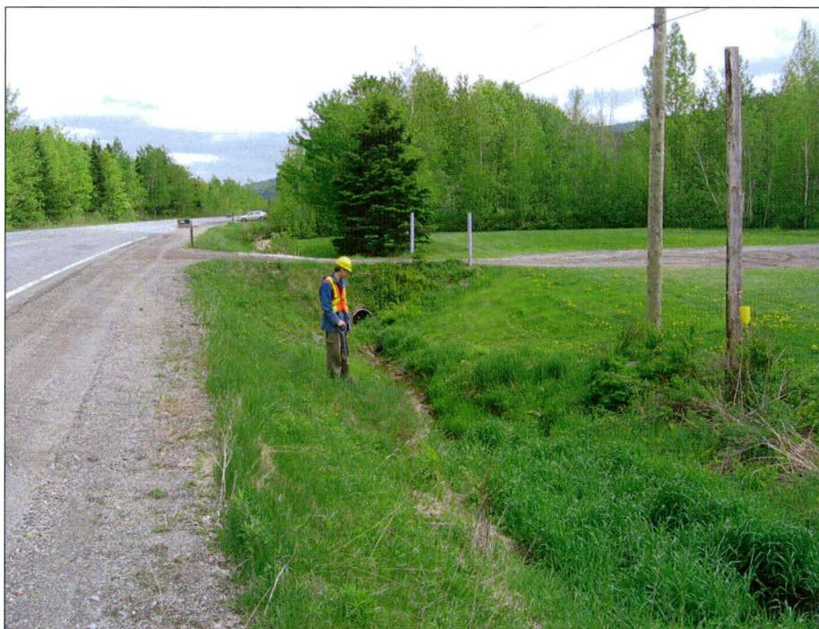
Photo 13 : Projet n° 154-05-0257, route 269, municipalité de Kinnear's Mills, ponceau situé au km 10+459, vue d'ensemble à partir du côté est de la route. Le technicien marque l'axe du ponceau. Direction nord (photo 154-05-0257-09).
