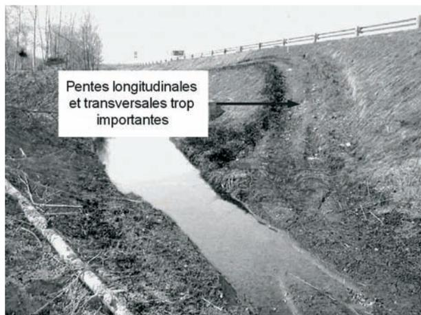
Figure 53: Exemple de pentes longitudinales et transversales trop importantes
