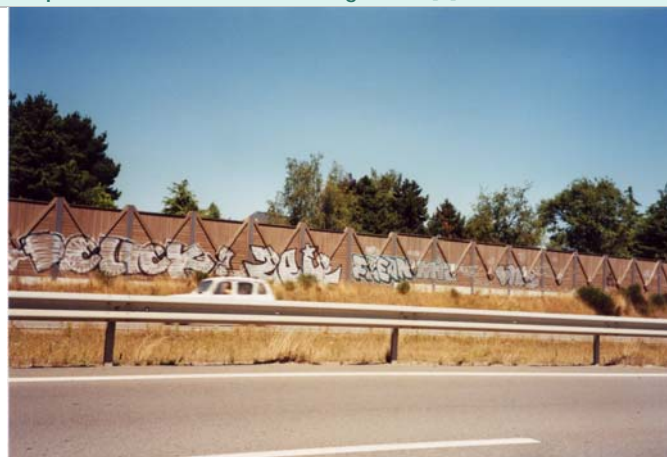
Illustration 15 - Exemple de l'effet visuel d'un mur tagué le long d'une autoroute (Cete de l'Ouest)
