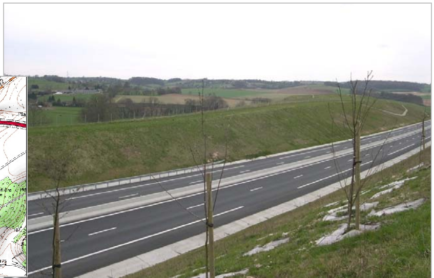
Illustration 1 - Merlon réalisé avec des matériaux mis en dépôt le long de l'A29 à Flamets Frétils pour protéger la commune en contre-bas du tracé de l'autoroute (Cete Normandie-Centre)
