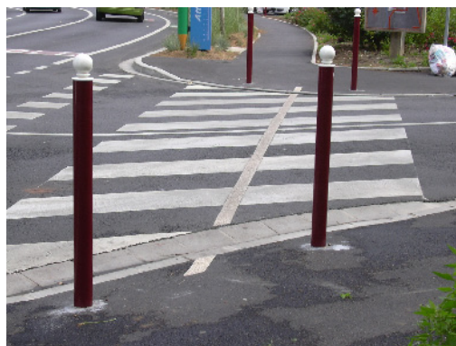
Pas de BEV ; le fil d'Ariane est légèrement prolongé au-delà de fil d'eau dans un matériau identique (Photo : Certu)
