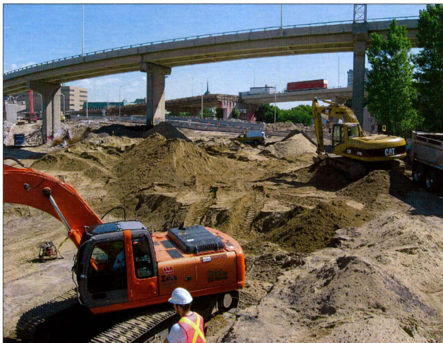
Photo 1 : Projet n° 154-99-0722, vue de la zone des travaux, autoroute Dufferin-Montmorency, ville de Québec. Direction nord-est (photo 154-99-0722-15).
