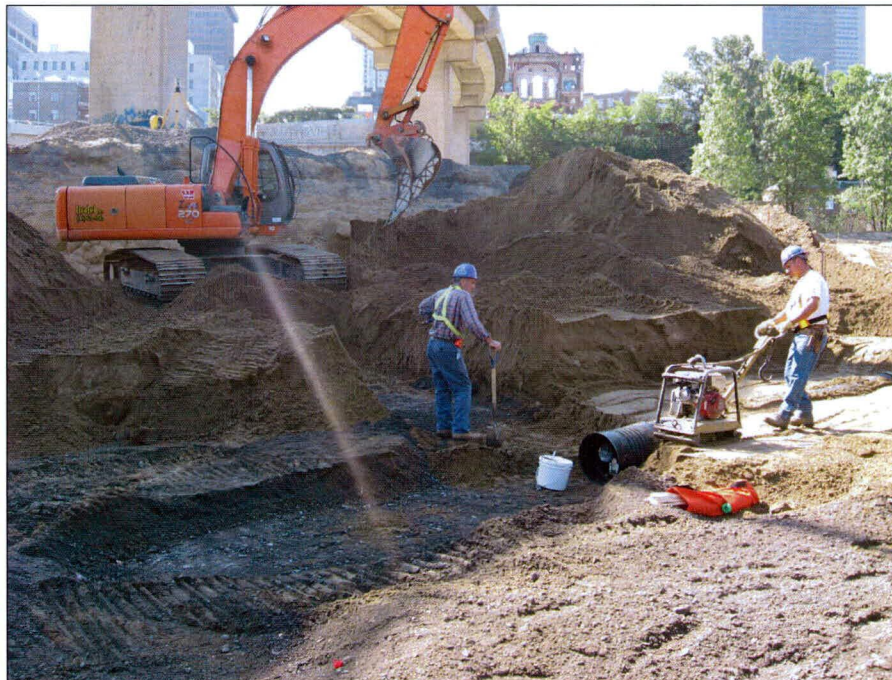
Photo 2 : Projet n° 154-99-0722, vue de l'excavation pour la pose de canalisations entre les regards RP8 et RP9, autoroute Dufferin-Montmorency, ville de Québec. Direction sud-est (photo 154-99-0722-20)
