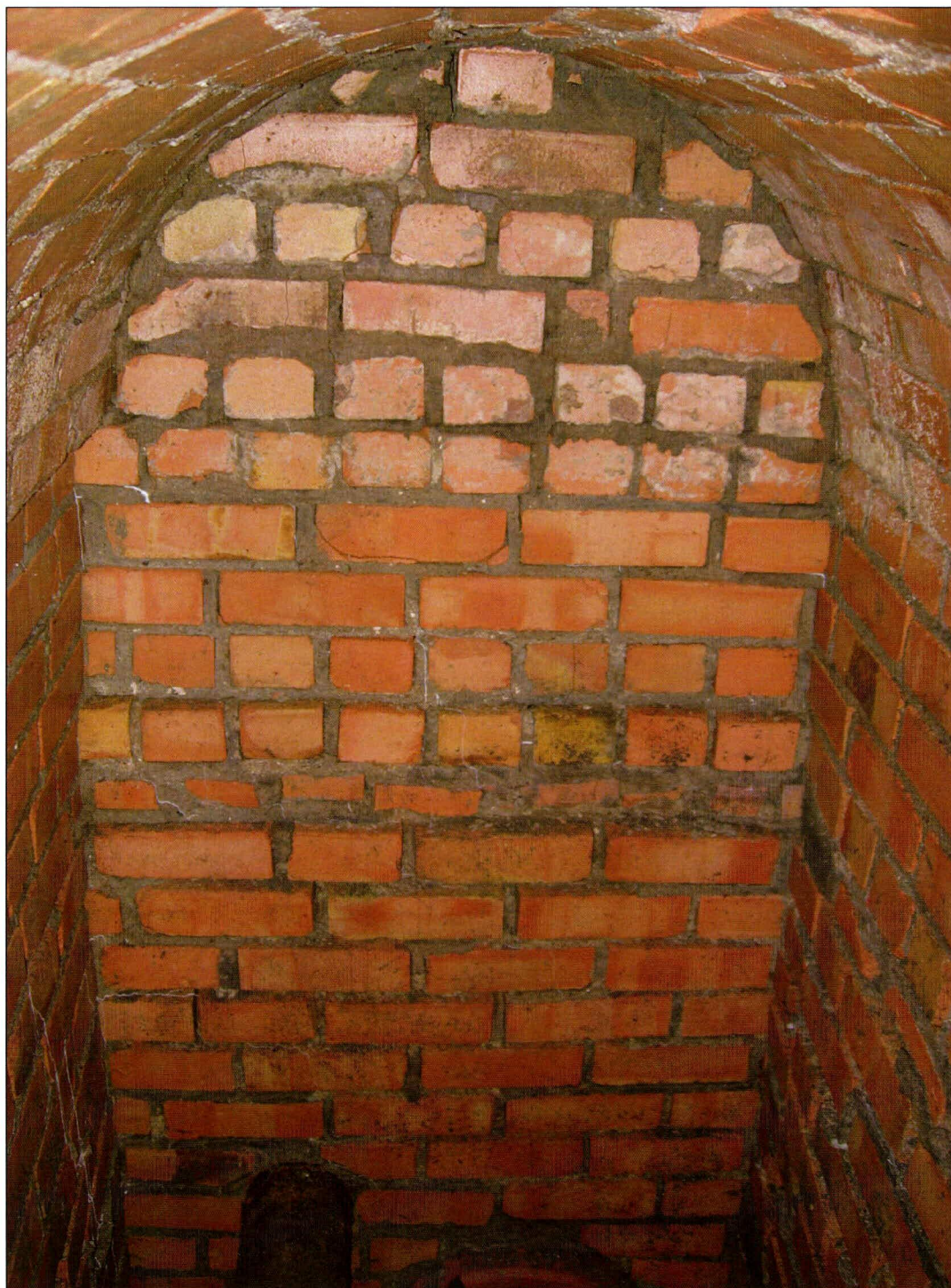
Photo 3 : Projet n° 154-99-0722, mur du fond de la voûte ouest du regard de briques, autoroute Dufferin-Montmorency, ville de Québec. Direction ouest (photo 154-99-0722-9).
