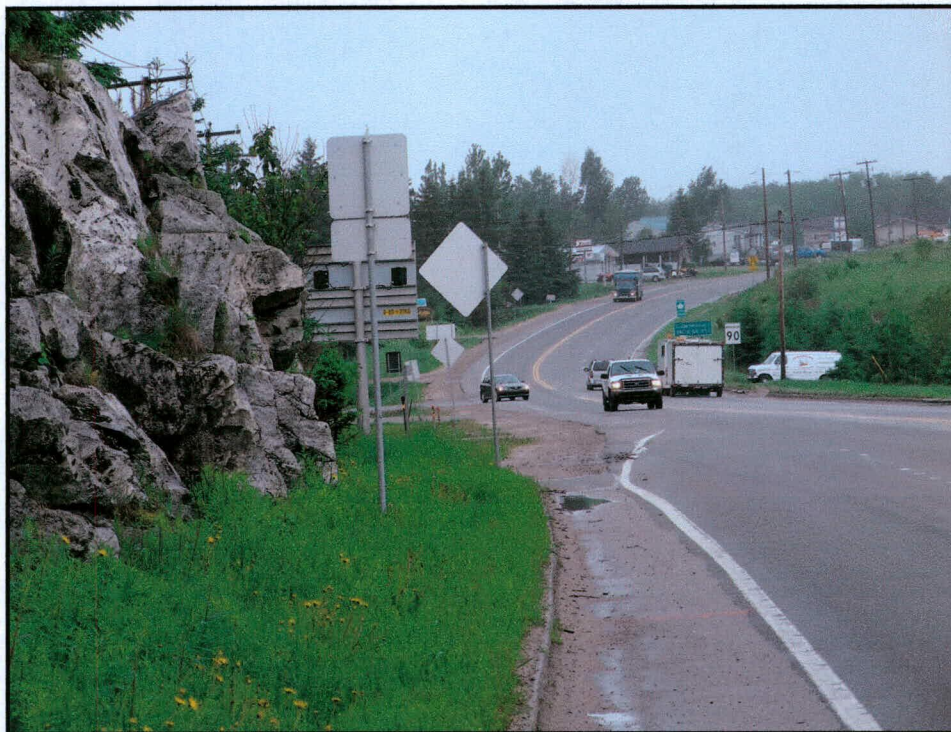
Photo 11 Projet n°154-86-0730 (20-6515-8625-G), route 117, Ville de Mont-Laurier, secteur 5, km 3+000, côté sud de la route, vers l'ouest.
