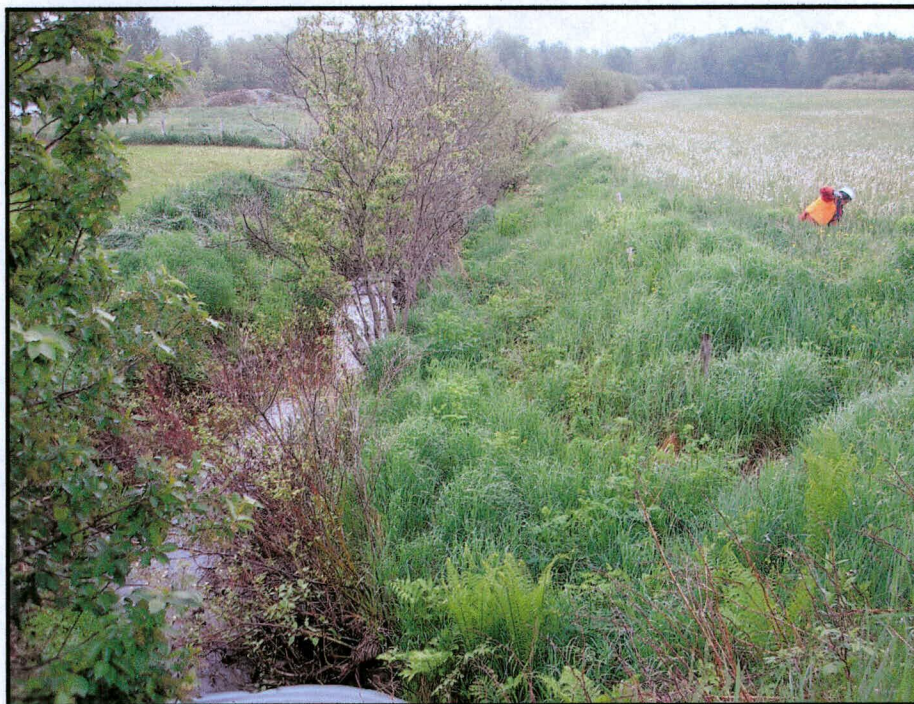
Photo 31 Projet n°154-99-1227 (20-5575-9911), route 309, municipalité de Saint-Aimé-du-Lac-des-îles, côté est, vue générale du ruisseau, vers l'est.
