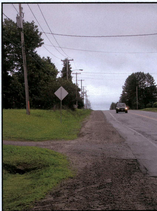
Photo 8 Projet n°154-86-0730 (20-6515-8625-G), route 117, Ville de Mont-Laurier, secteur 4, côté sud de la route, vers l'est.
