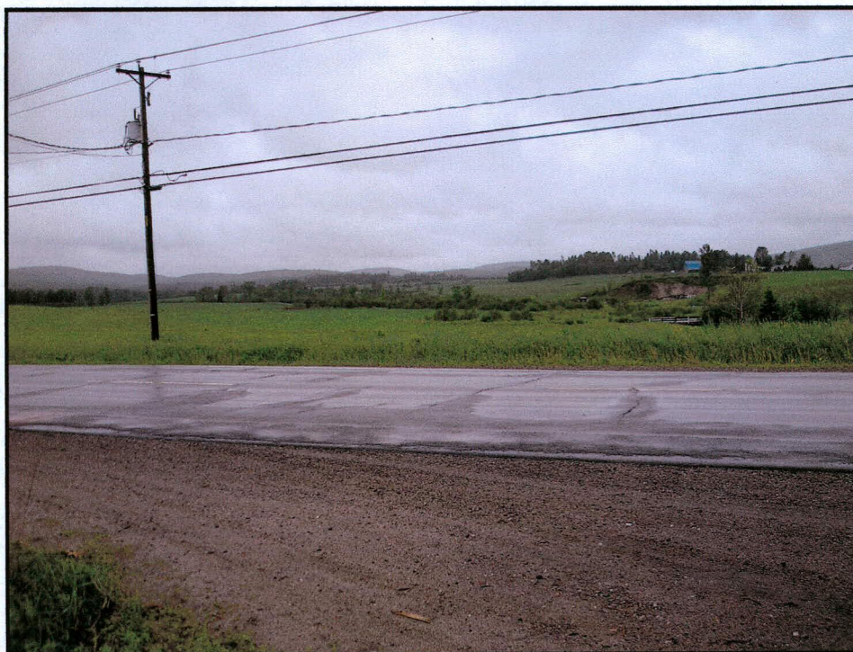
Photo 2 Projet n°154-86-0730 (20-6515-8625-G), route 117, Ville de Mont-Laurier, limite ouest du secteur 1, vers le nord.
