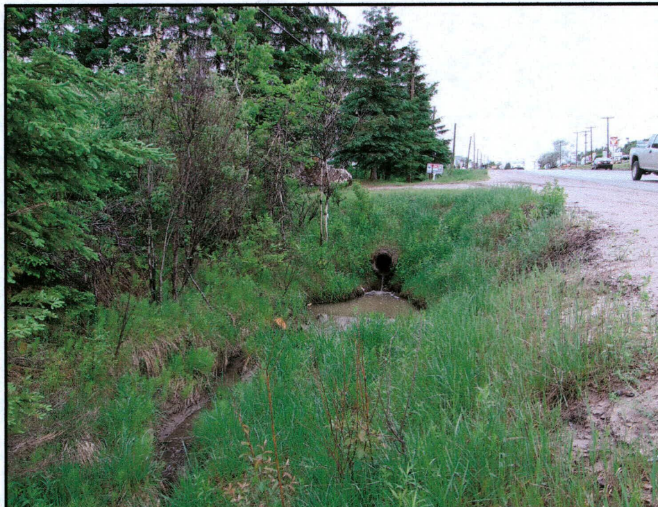
Photo 1 Projet n°154-86-0730 (20-6515-8625-G), route 117, Ville de Mont-Laurier, vue du fossé et ponceau, limite est des travaux, vers l'ouest.
