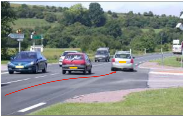
Évitement par la droite d'un véhicule en tourne-à-gauche
