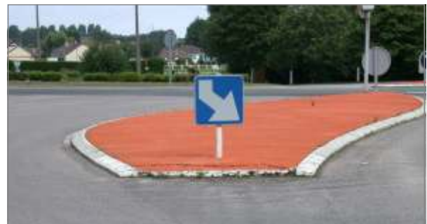
Branche RD226 en venant de Touffreville-sur-Eu Îlot tronqué utilisé pour faire des tourne-à-gauche par la droite
