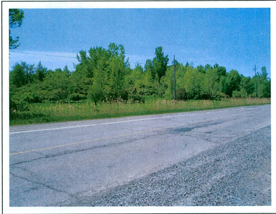
Photo 5 : (N-1:034) lot 16-P, secteur 1 (Châteauguay) : Terrain en milieu boisé et en friche, vue vers le sud.
