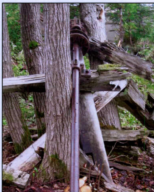
Photo 35 : Projet n° 154-99-0643, partie supérieure de la pièce en métal associée au moulin dans le secteur "C", CkEm-1-1C200, en direction nord (MRLOU08.58)
