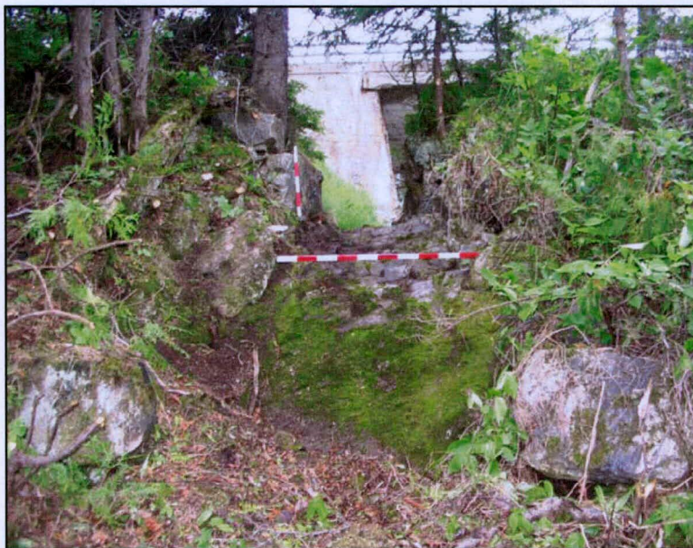
Photo 40 : Projet n° 154-99-0643, canal d'amenée d'eau (CkEm-1-1C500), secteur "C", en direction nord-ouest (MRLOU08.84)
