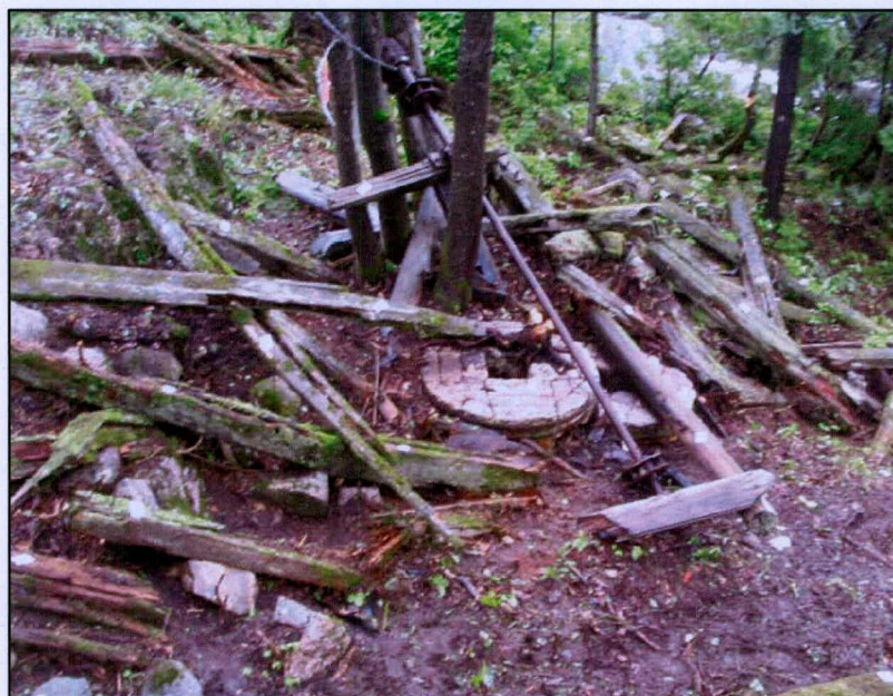
Photo 25 : Projet n° 154-99-0643, concentration de pièces de bois associées au moulin situé à l'ouest dans le secteur "C", en direction nord (MRLOU08.128)
