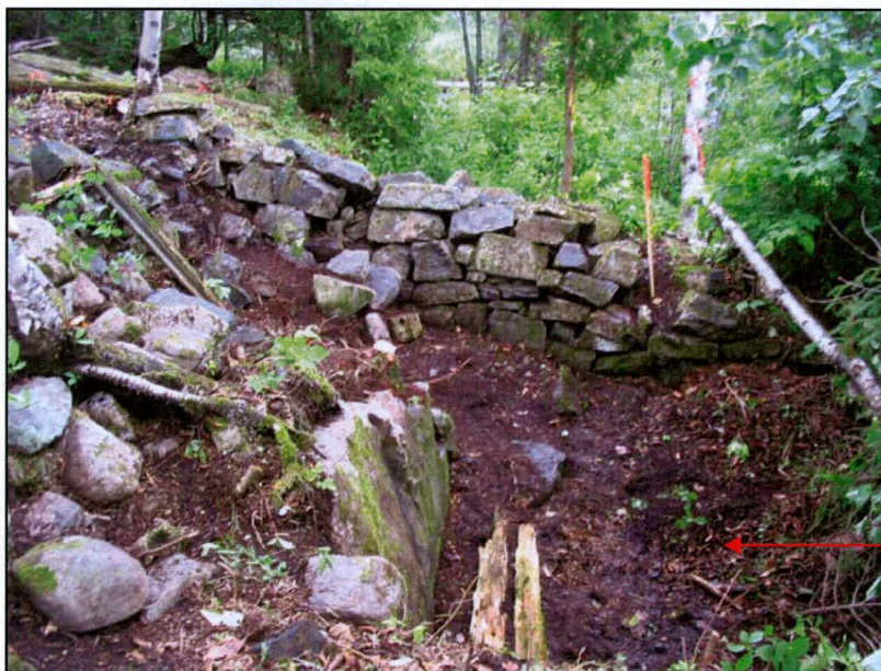
Photo 16 : Projet n° 154-99-0643, partie nord-est du bâtiment "A" où une partie plus profonde peut être observée, en direction nord-est (MRLOU08.54)
