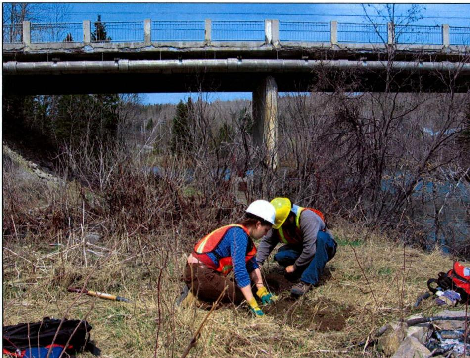
Photo 8 : Sondage réalisé dans des alluvions de la rivière du Grand Babos Ouest, du côté sud de la route 132, au km 3+500, ville de Chandler, direction nord-ouest (20-3172-7802-C-07-NUM1-11)
