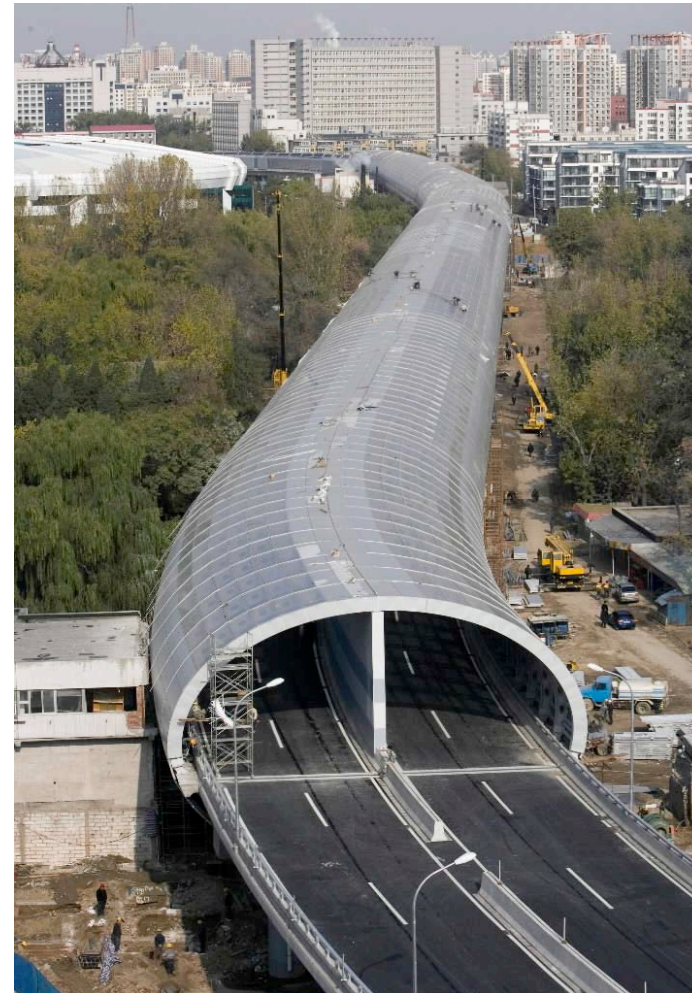
Toiture légère en polycarbonate Tunnel Zhanxi, Zoo de Beijing
