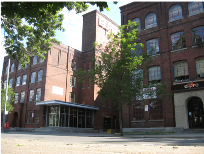
Le bâtiment Elpro, anciennement l'usine Tooke, rue de Courcelle.
