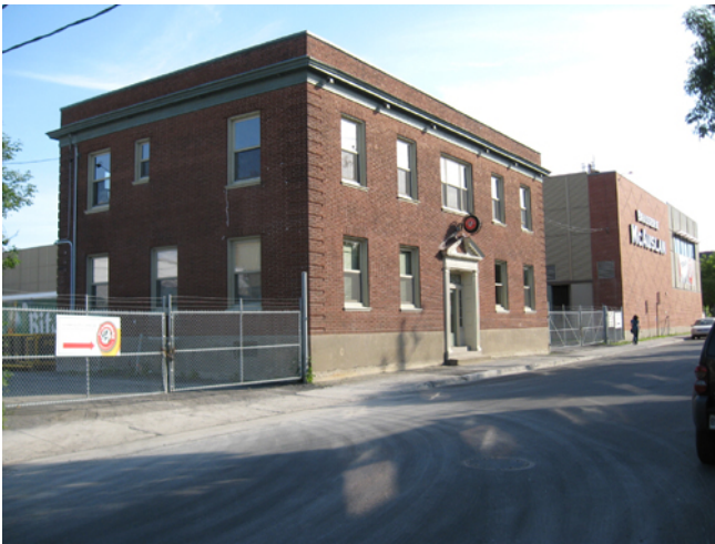
L'usine McAuslan, avec les anciens bureaux de la Maxwell, rue St-Ambroise.
