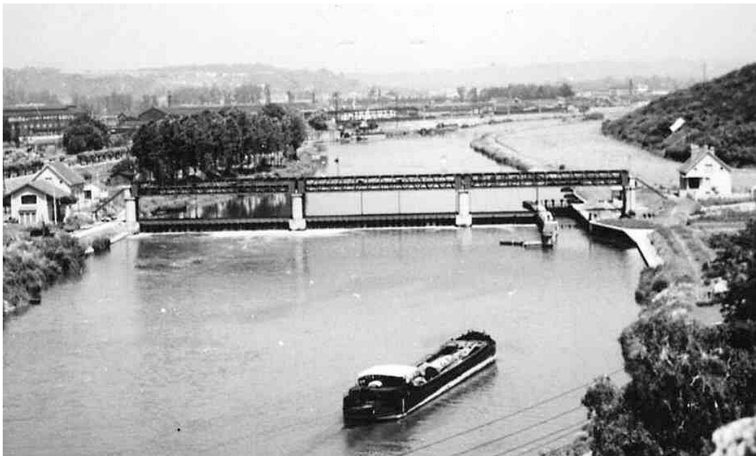
Photo 21 - L'ancien barrage de Creil (source)
