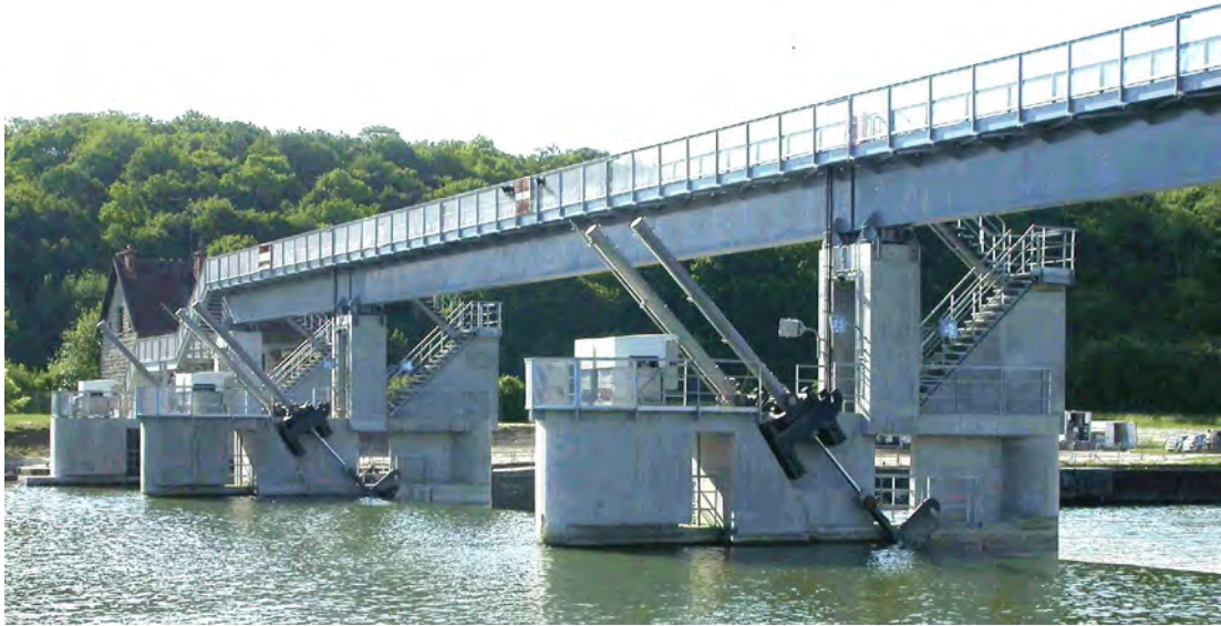
Photo 22 - Le nouveau barrage de Creil (LREP)
