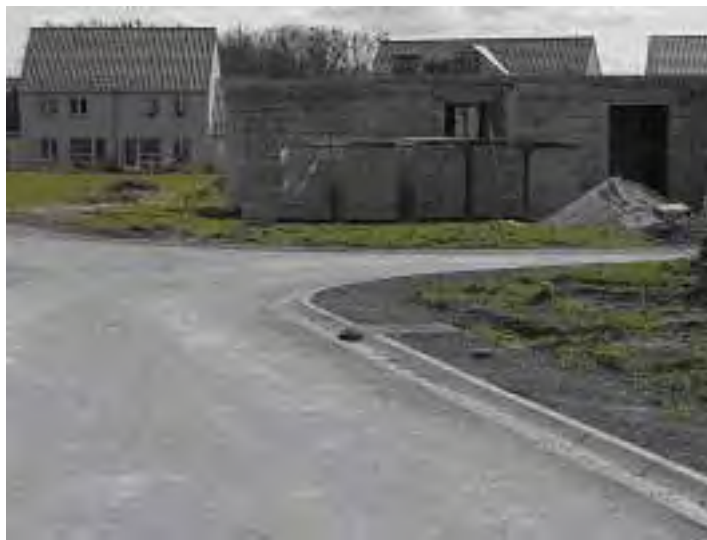
Lotissement en cours d'aménagement
