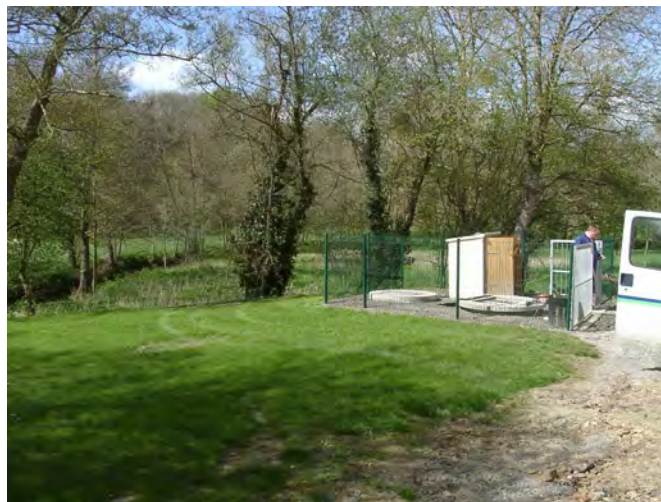
Poste de refoulement du centre bourg
