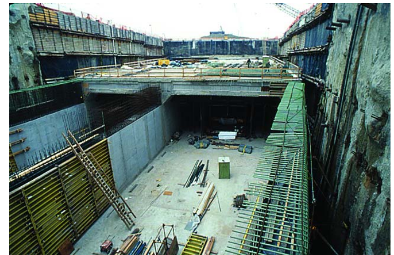
Construction d'un tronçon de tunnel dans East Boston.
